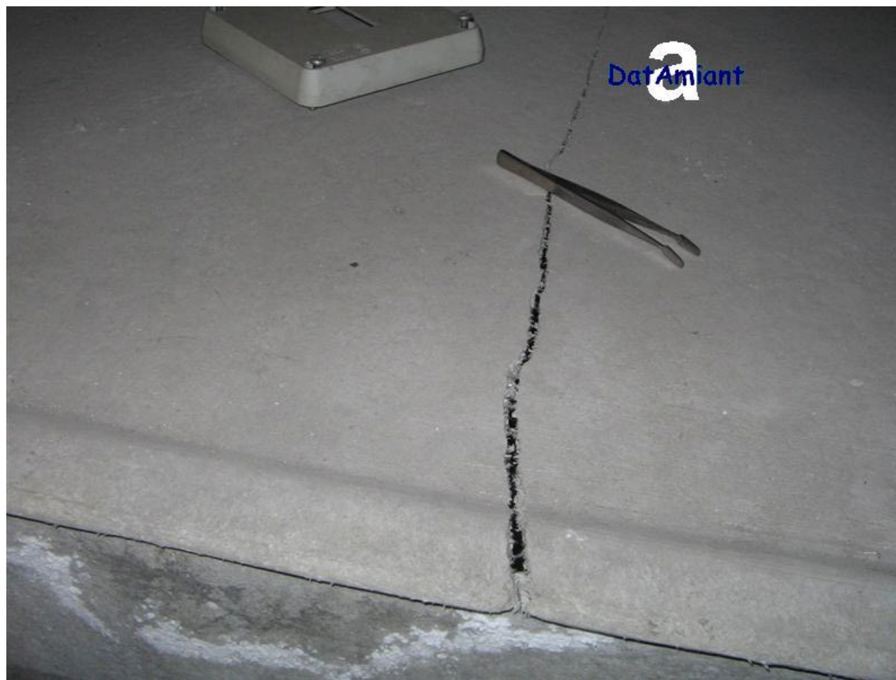
Locale seminterrato di edificio con uffici e appartamenti Coperchio danneggiato di serbatoio idrico in cemento amianto con ciuffi di fibre affioranti lungo la frattura (dettaglio)
