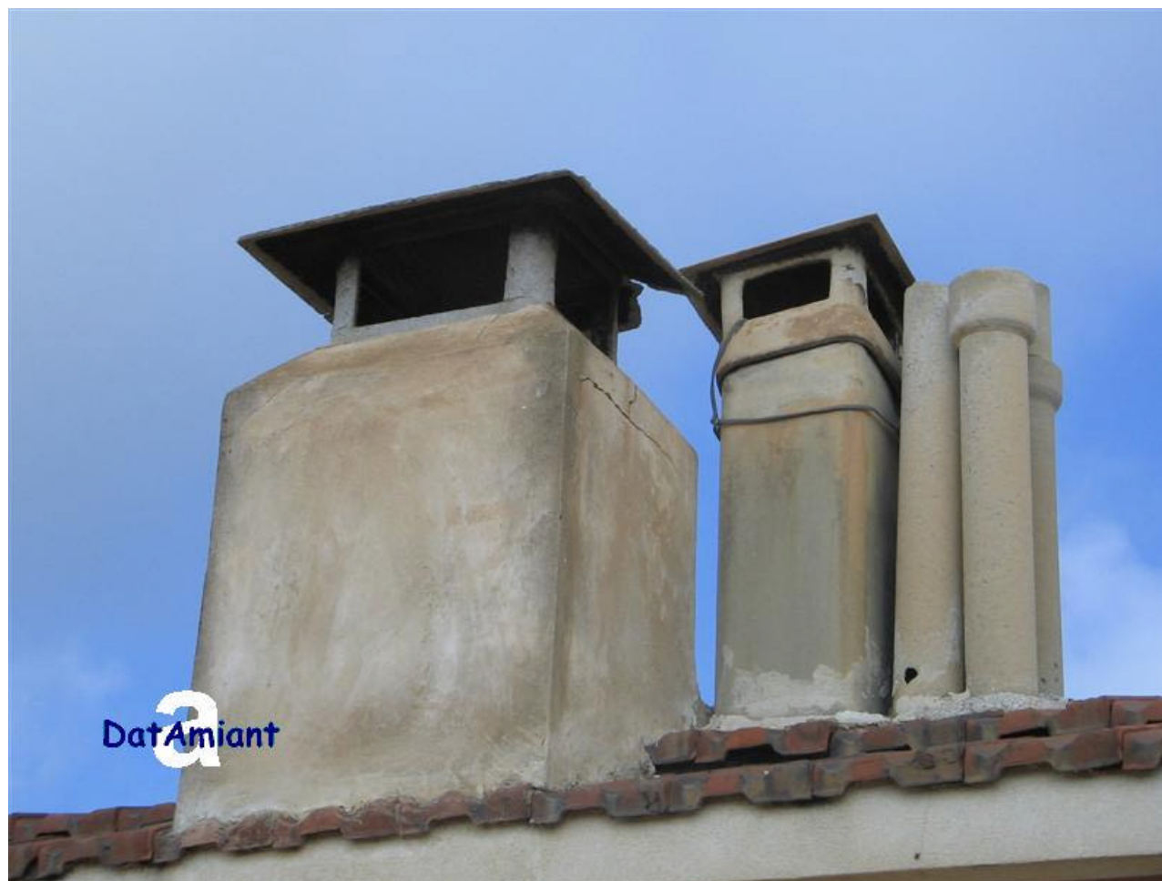
Copertura tetto edificio con uffici e abitazioni Comignoli di canne fumarie e condotte di ventilazione di impianti igienico-sanitari in cemento amianto
