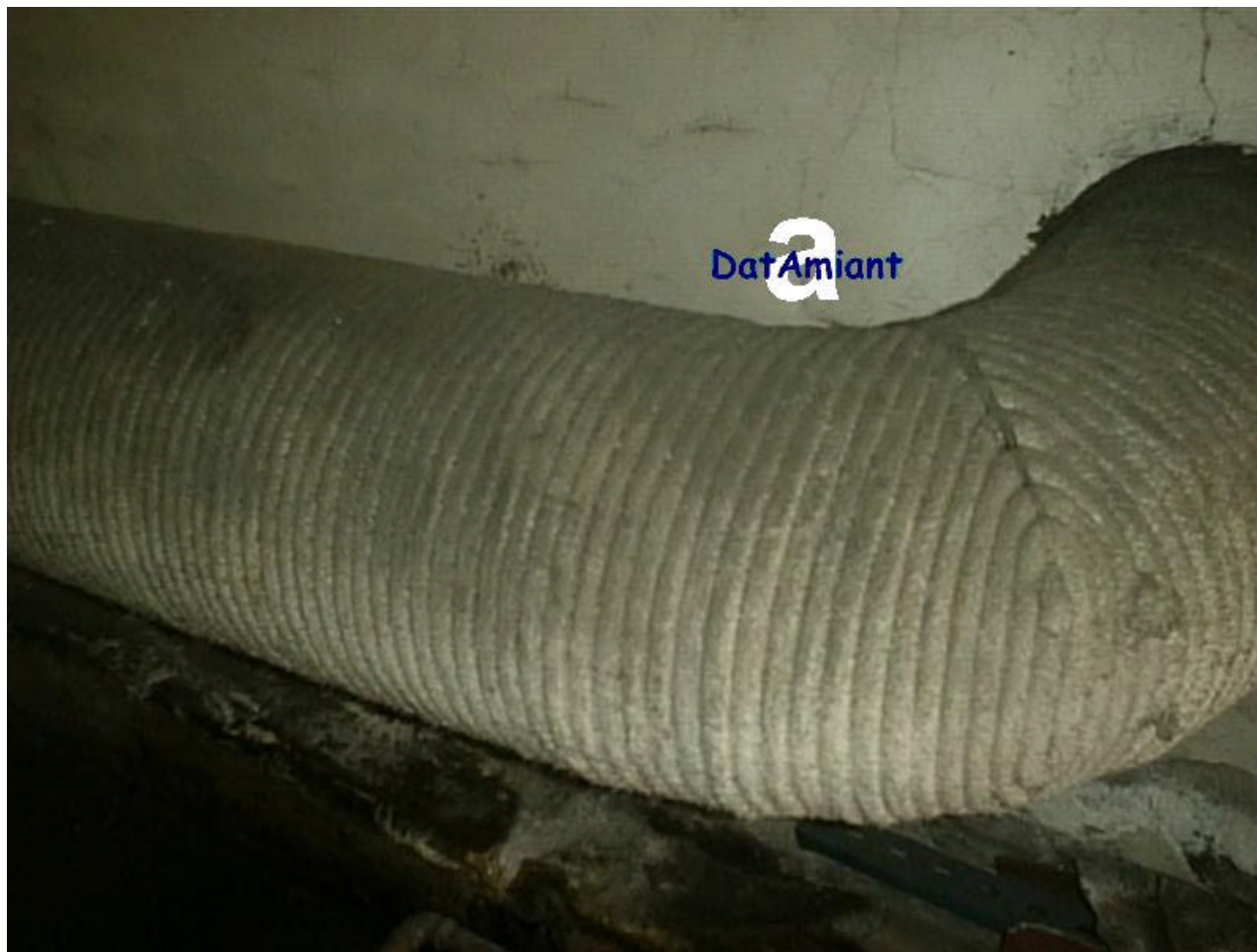
Locale caldaie di ospedale pediatrico Condotto di scarico fumi di caldaia coibentato con corda di crisotilo
