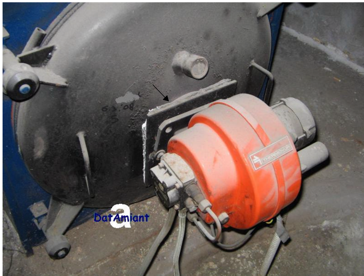
Locale caldaie di edificio con uffici e appartamenti Guarnizione di bruciatore a pannello multistrato contenente crisotilo
