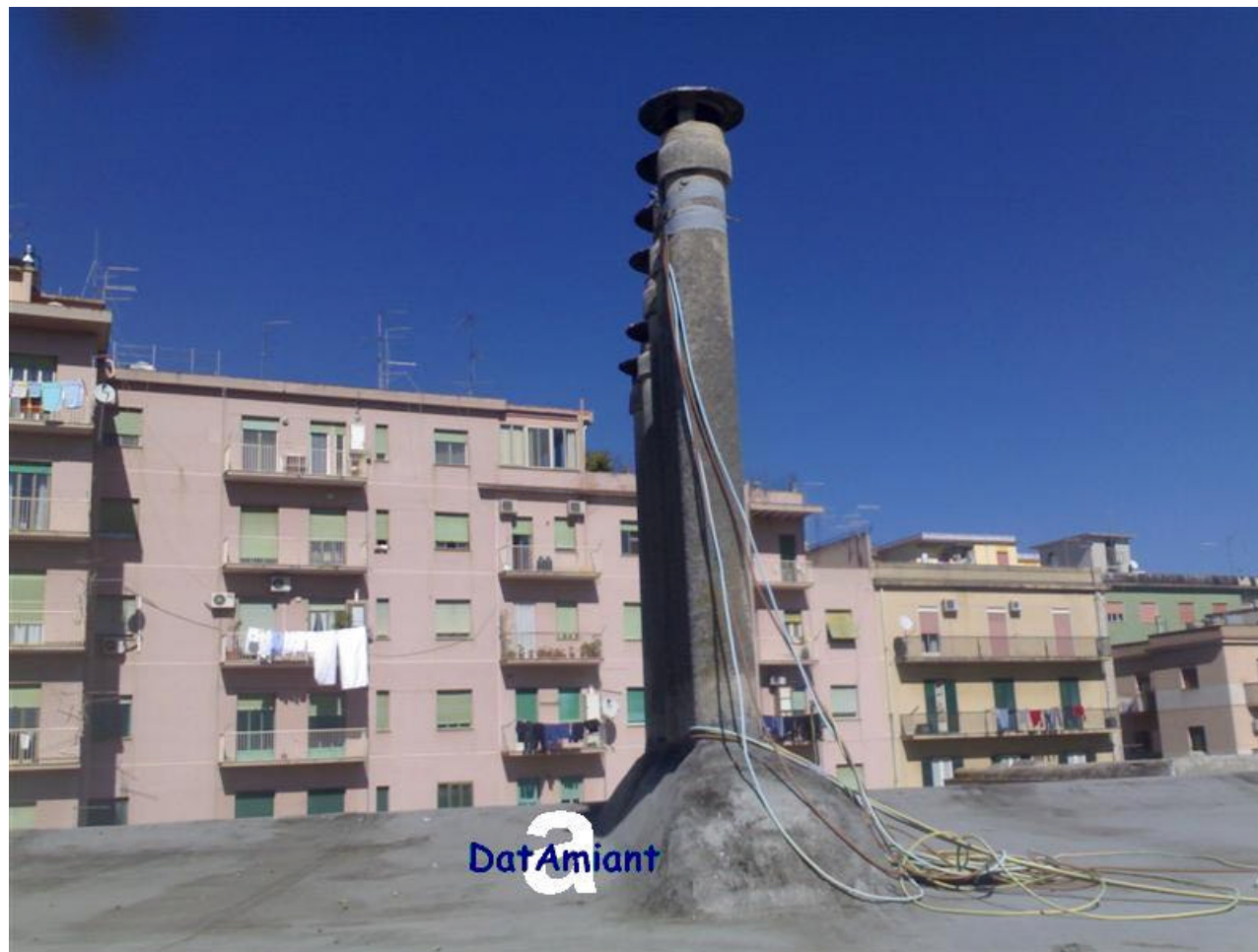
Tetto di edificio con uffici Gruppo di canne fumarie e comignoli in cemento amianto di vecchie cucine a legna dismesse
