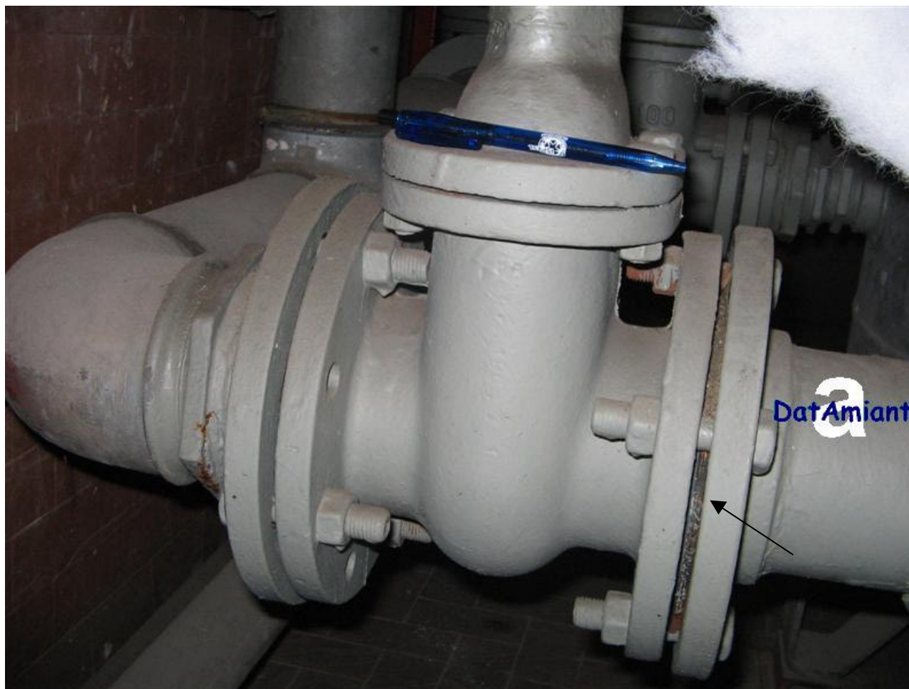
Centrale termica di edificio con uffici e appartamenti Flangie con guarnizioni contenenti crisotilo
