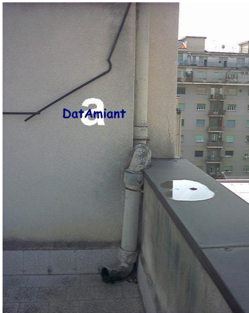
Terrazza di edificio con uffici Pluviale in cemento amianto
