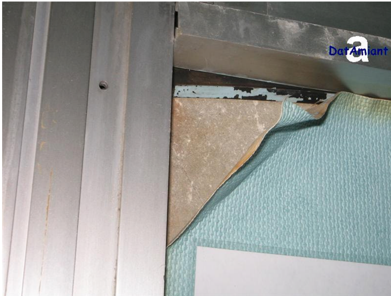
Interno di edificio di una banca ad uso CED Pannello contenente amianto crisotilo danneggiato (dettaglio)
