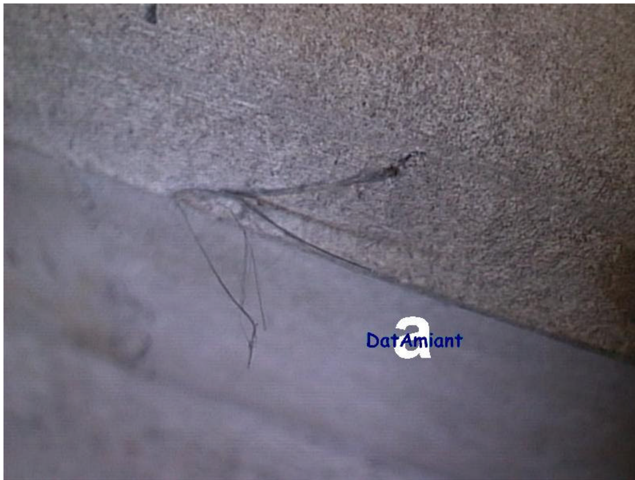
Superficie di serbatoio idrico in cemento amianto Ciuffo di fibre di dimensioni centimetriche affiorante
