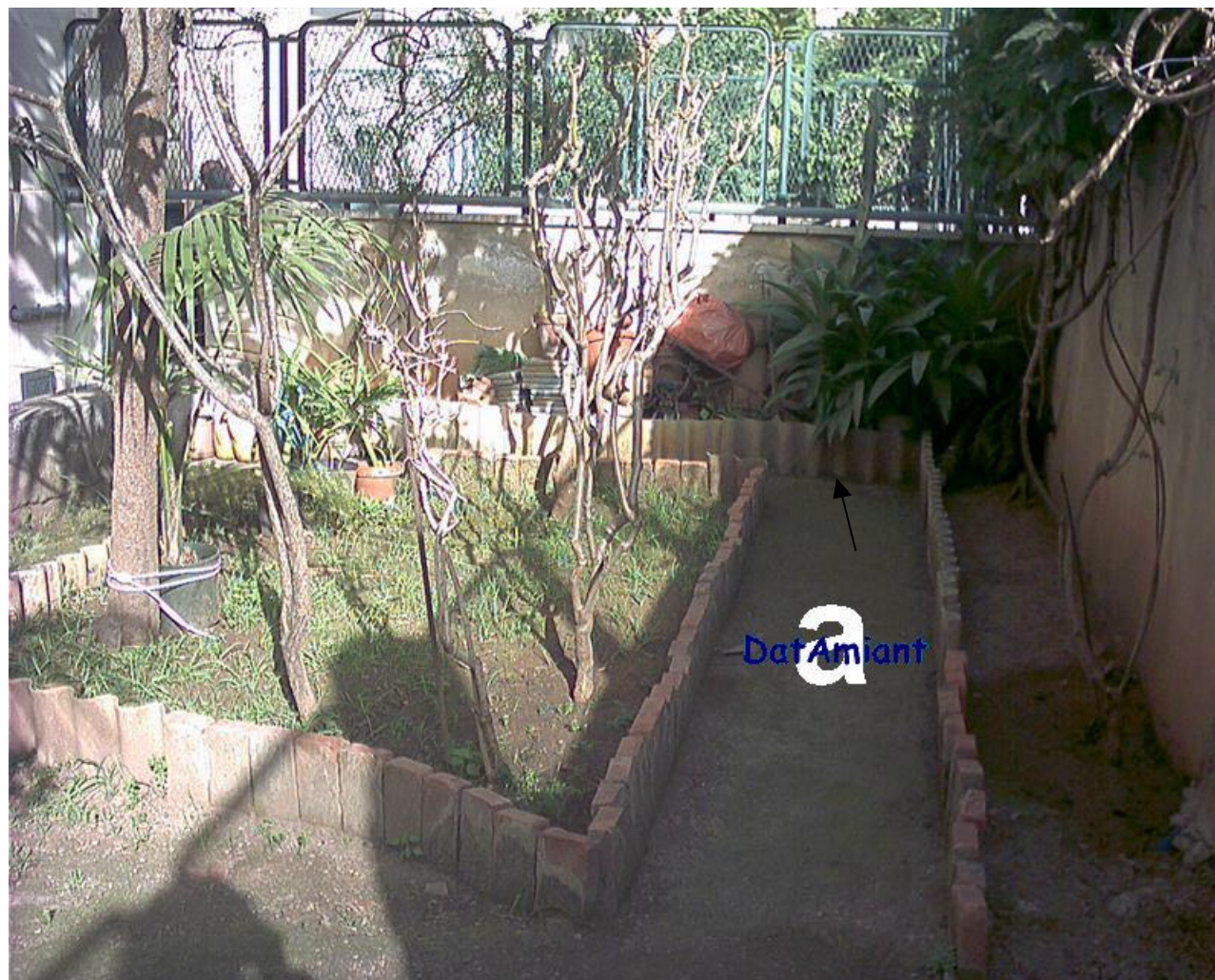
Area esterna di appartamento al piano terreno Aiuole contornate con pezzi di lastre ondulate in cemento amianto
