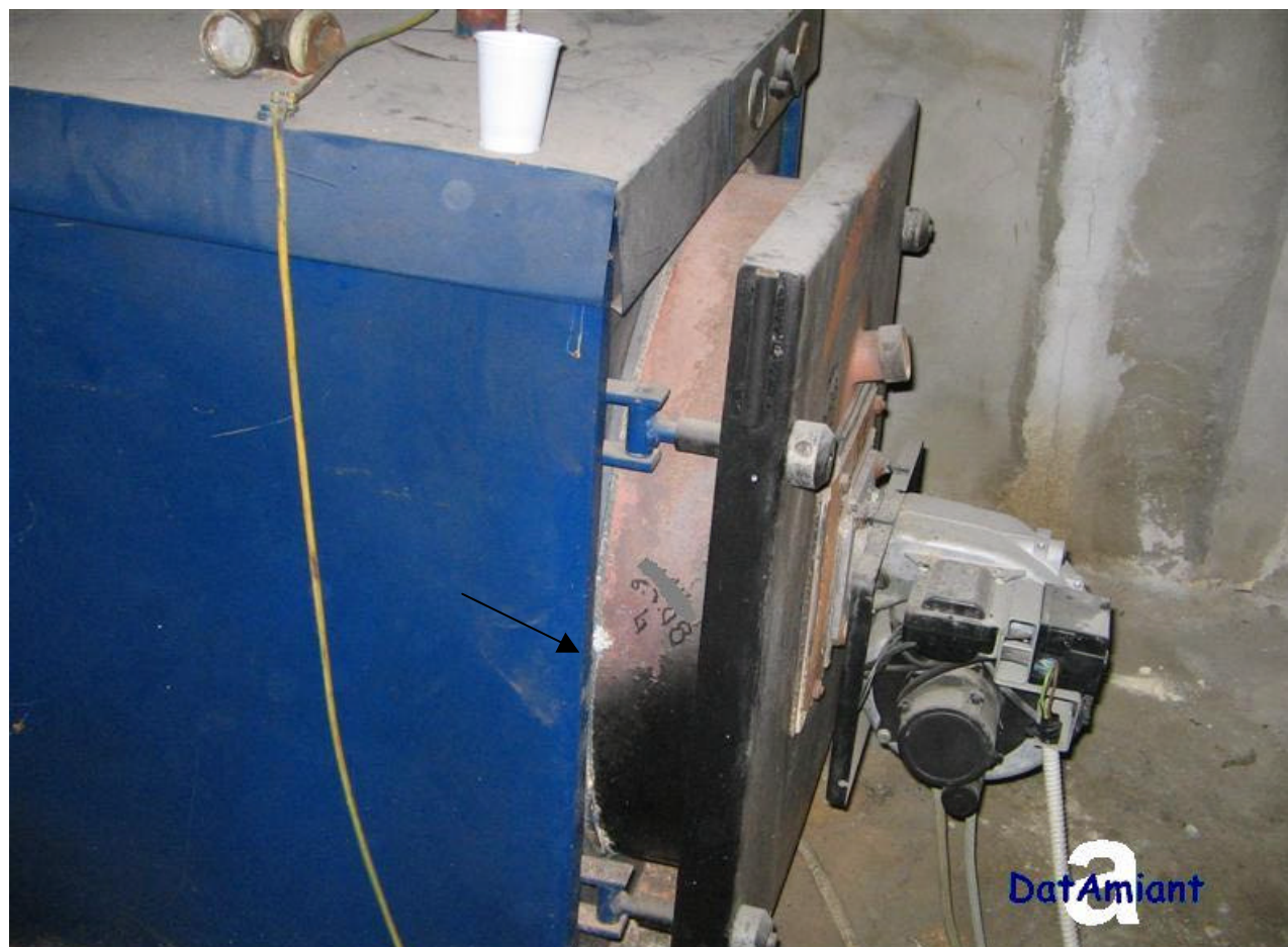
Locale caldaie di edificio con uffici e appartamenti Guarnizione di caldaia a treccia contenente fibre di crisotilo e fibre di natura organica
