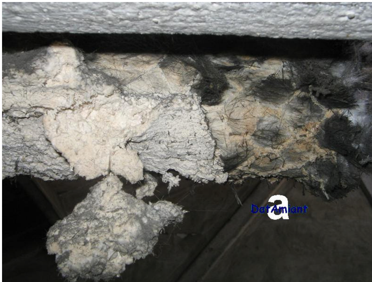
Locale caldaie di azienda di tessitura e filatura dismessa Tubazione coibentata con rivestimento esterno contenente amosite (dettaglio)
