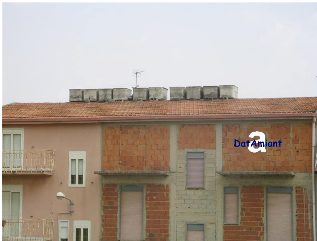
Tetto di edificio con abitazioni Gruppo di serbatoi idrici in cemento amianto
