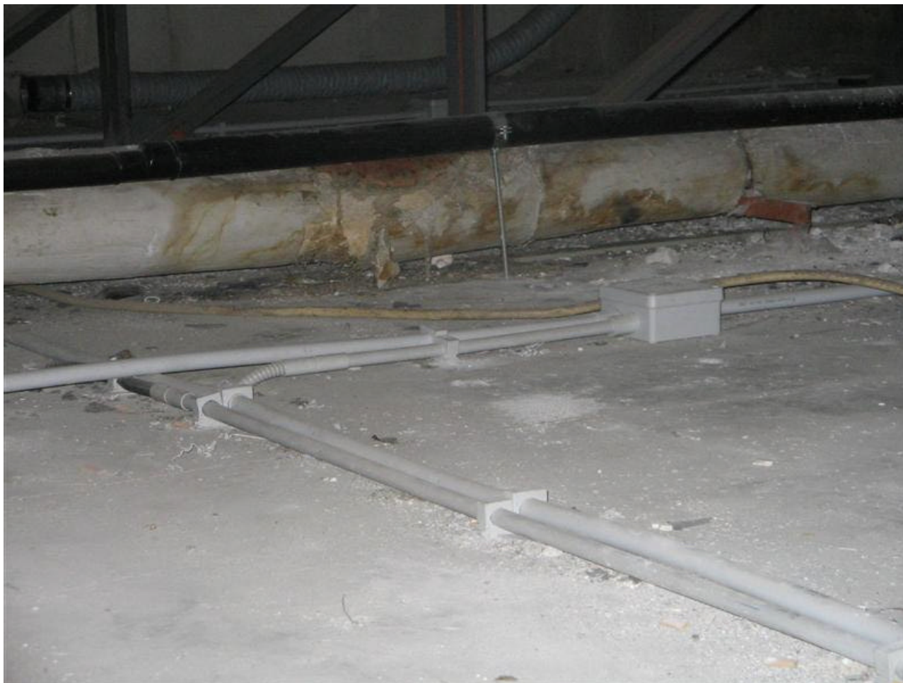
Interpiano tecnico di edificio di banca Tubazione calda coibentata con rivestimento esterno di impasto di cemento e crisotilo deteriorato (dettaglio)
