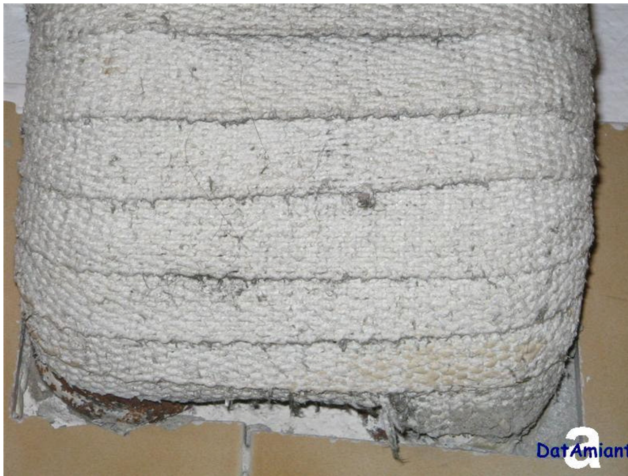
Toilette di ristorante Condotto di ventilazione fasciato con tessuto di crisotilo (dettaglio)
