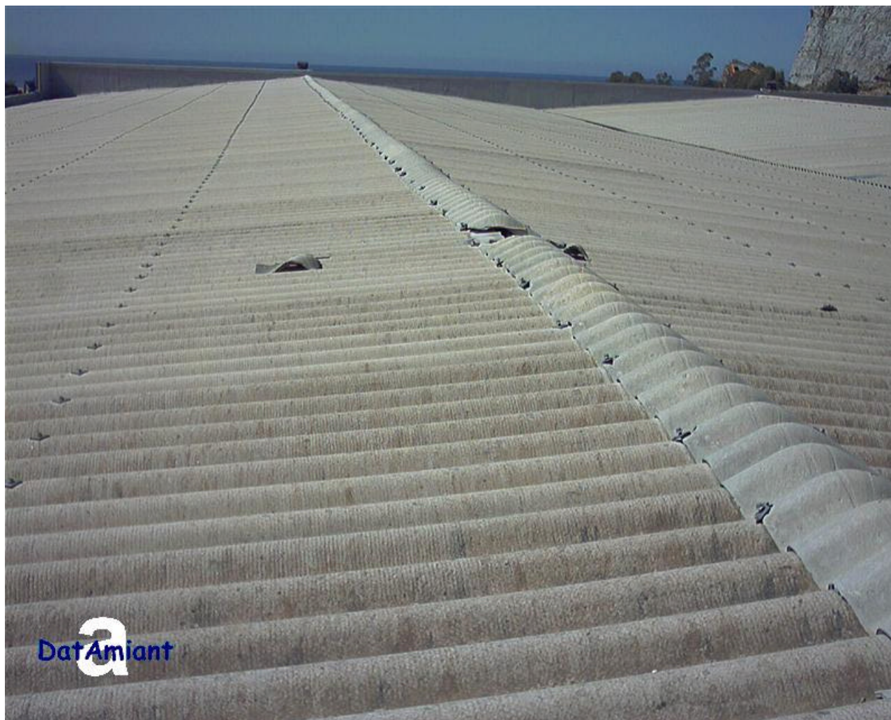
Capannone industriale Tetto con copertura in lastre ondulate in cemento amianto
