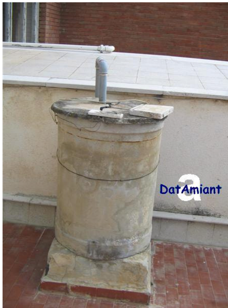
Terrazza di edificio con uffici e appartamenti Vaso espansore di impianto riscaldamento in cemento amianto
