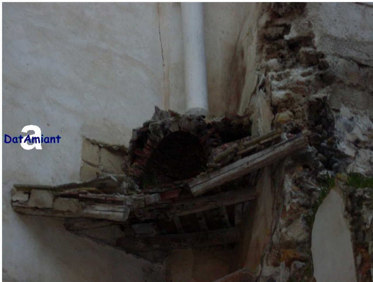
Abitazione sventrata da terremoto Forno a legna con canna fumaria in cemento amianto
