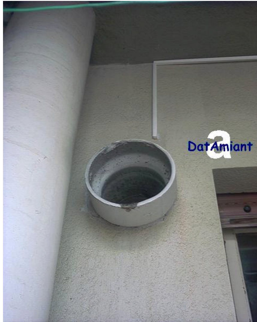
Balcone di un appartamento Tubo di uscita fumi in cemento amianto di cappa da cucina
