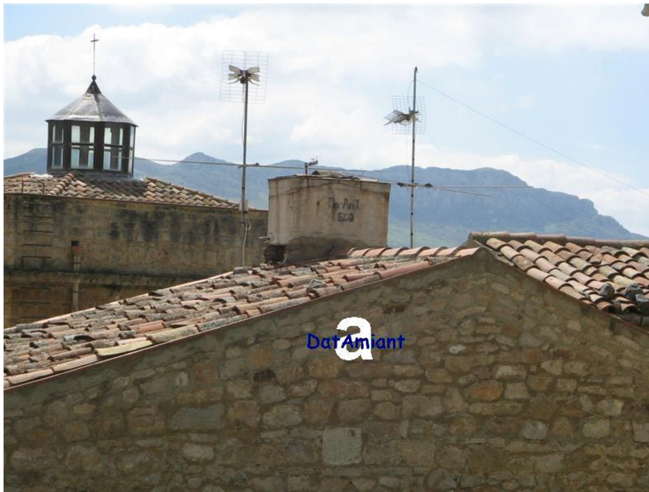
Tetto di abitazione Serbatoio idrico da 500 l in cemento amianto
