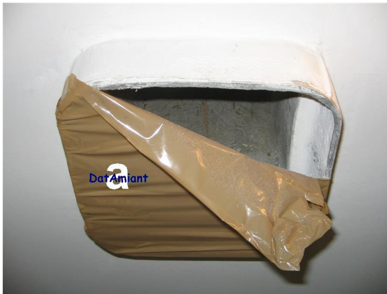
Locale di servizio di ambulatorio sanitario Bocca di entrata a soffitto di canna fumaria in cemento amianto di inceneritore per rifiuti sanitari dismesso (dettaglio)
