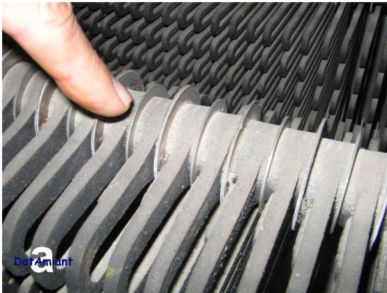
Sotto Stazione Elettrica SSE delle Ferrovie Resistenze prova terra con guarnizioni in amianto (dettaglio)
