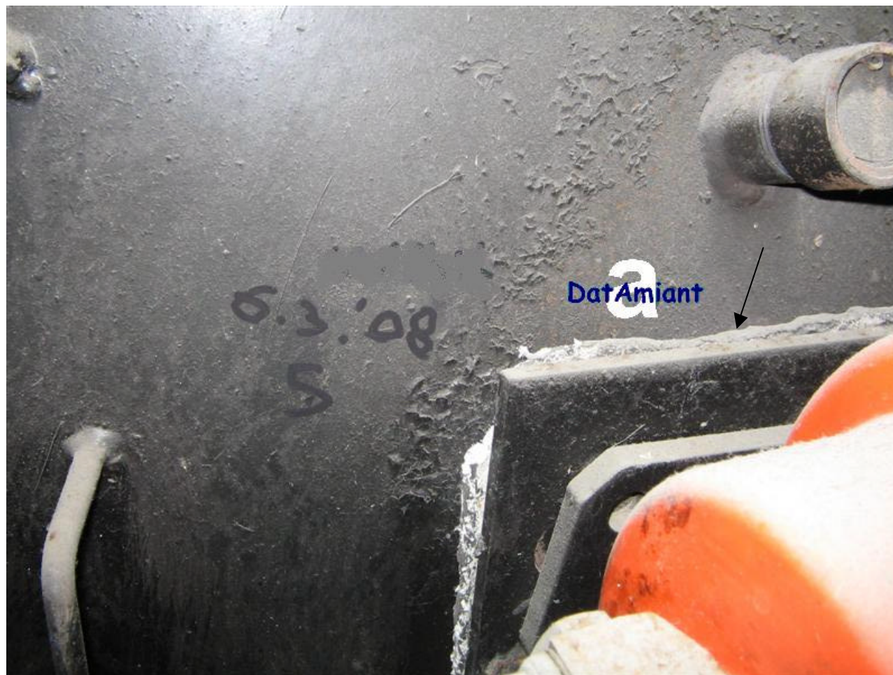
Locale caldaie di edificio con uffici e appartamenti Guarnizione di bruciatore a pannello multistrato contenente crisotilo (dettaglio)
