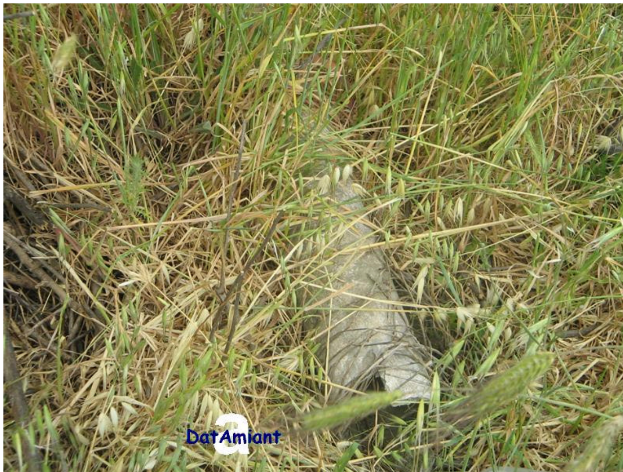
Campagna Tubo idrico in cemento amianto dismesso
