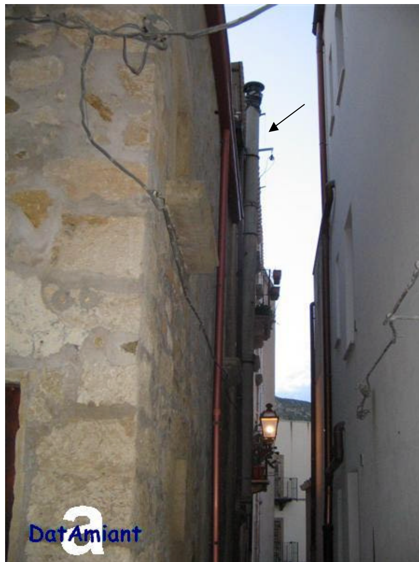
Edificio per abitazioni Canna fumaria in cemento amianto
