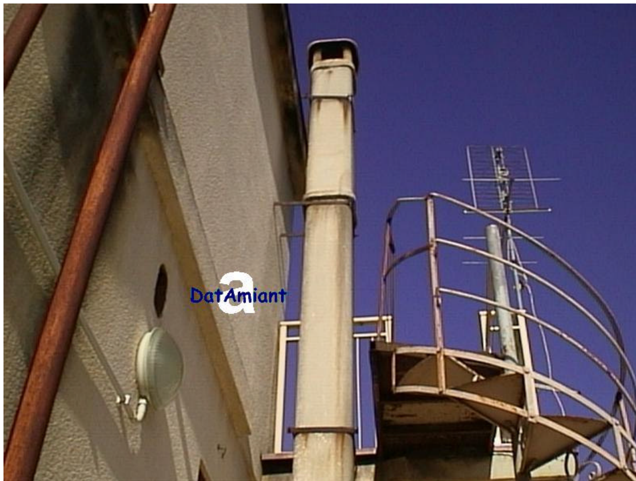
Terrazza di edificio con appartamenti Tratto finale di canna fumaria di caldaia in cemento amianto (dettaglio)
