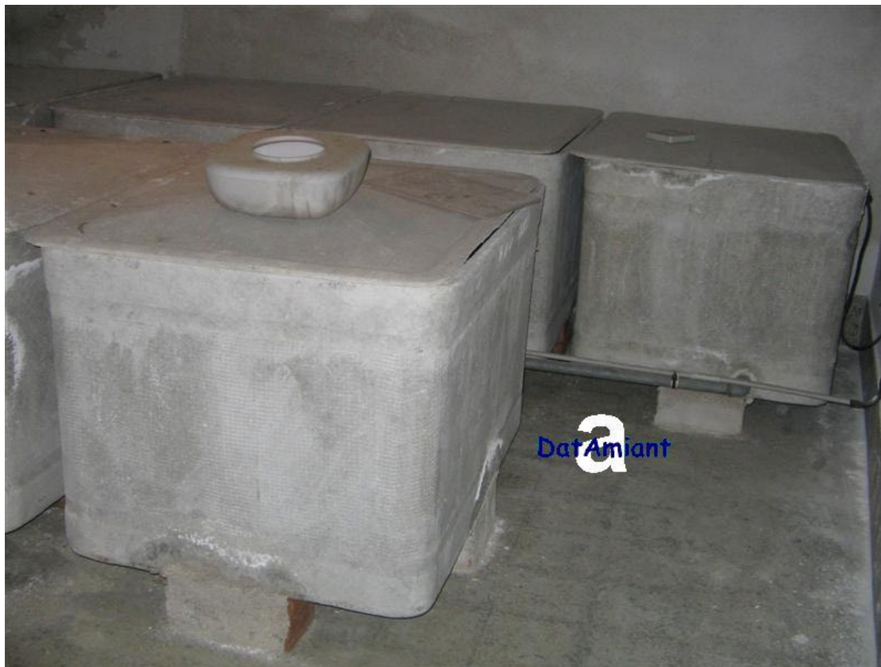
Locale seminterrato di edificio con uffici e appartamenti Serbatoi idrici da 500 l in cemento amianto
