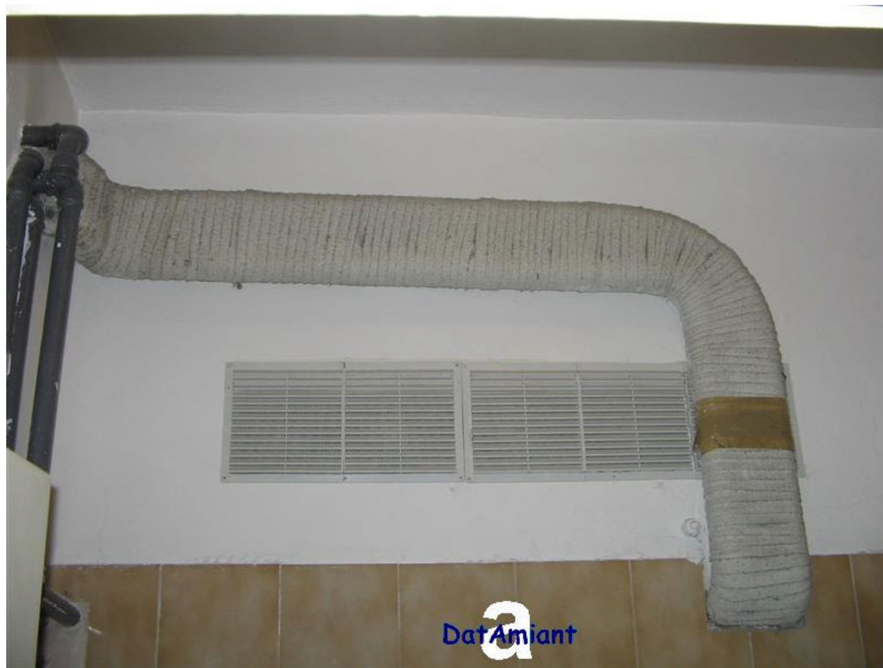
Toilette di ristorante Condotto di ventilazione fasciato con tessuto di crisotilo
