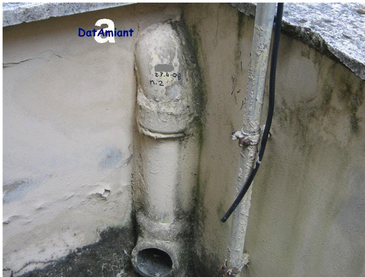
Balcone di edificio con uffici Pluviale in cemento amianto
