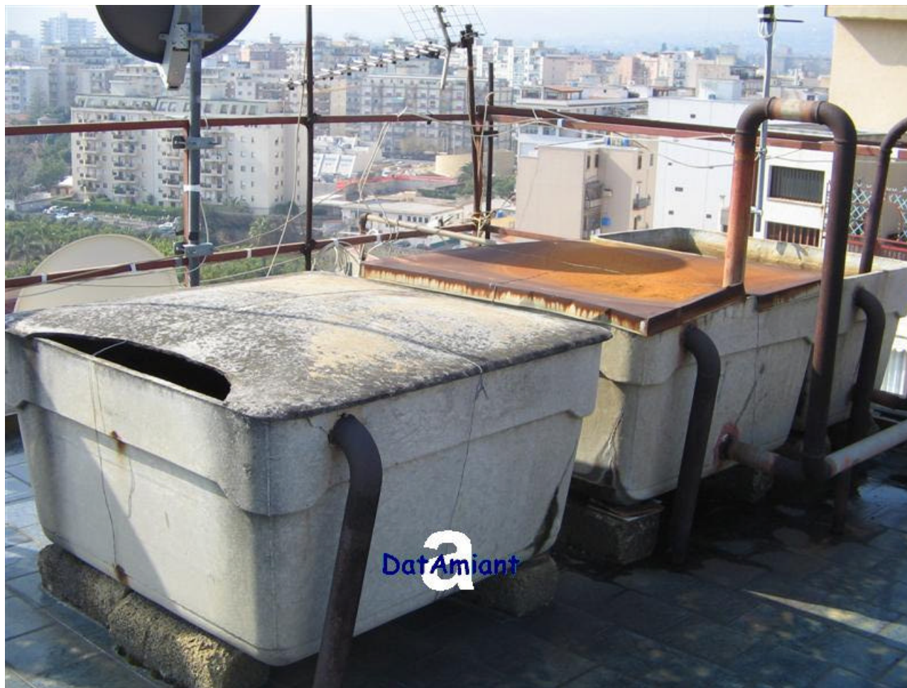
Piano attico di edificio con uffici e appartamenti Vasi espansori di impianto riscaldamento in cemento amianto (dettaglio)
