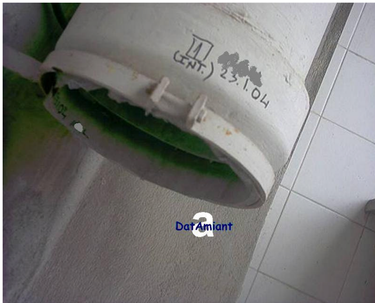
Balcone di un appartamento Tubo per rifiuti domestici in cemento amianto privo di base con sportello e parzialmente danneggiato (dettaglio)
