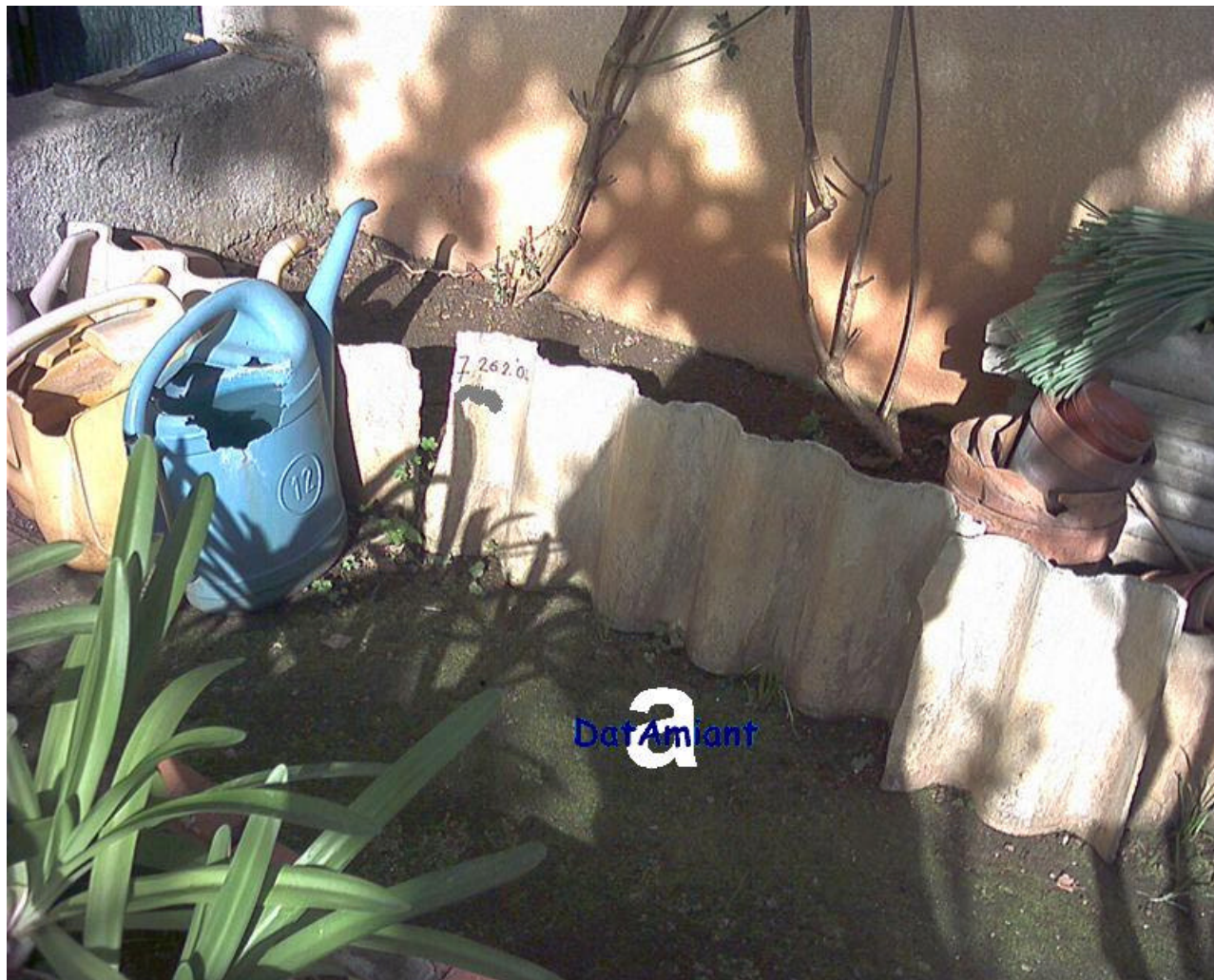
Area esterna di appartamento al piano terreno Aiule contornate con pezzi di lastre ondulate in cemento amianto (dettaglio)
