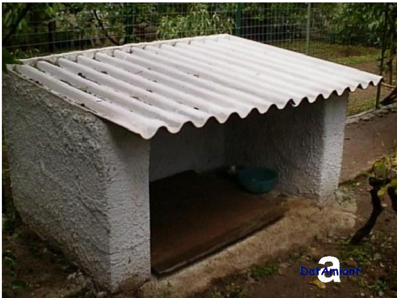
Giardino di villetta Tettoia di cuccia con lastra di cemento amianto
