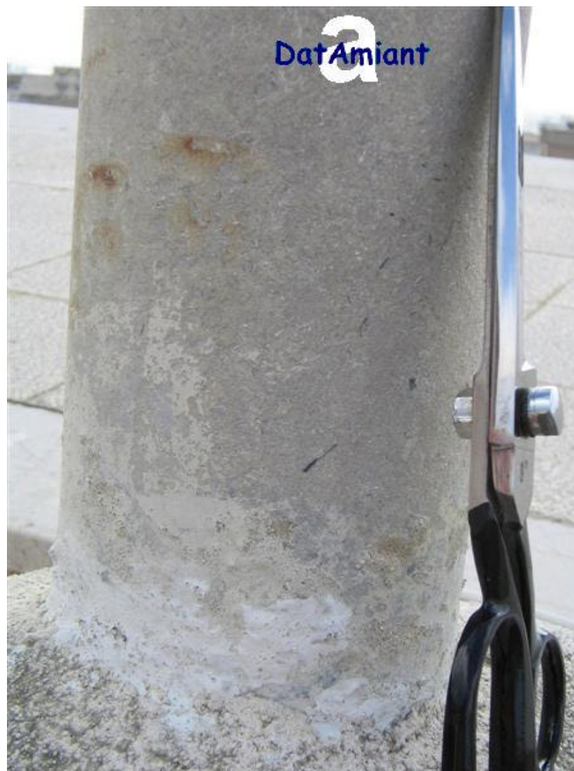
Terrazza di edificio con uffici ed appartamenti Superficie cementizia di canna di sfiato con fibre di amianto affioranti (dettaglio)
