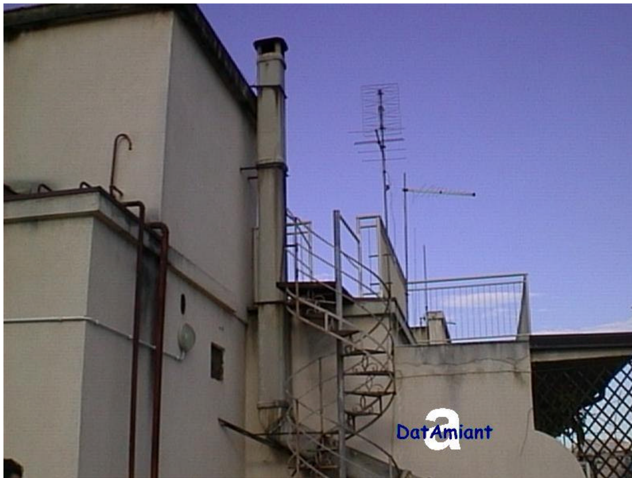
Terrazza di edificio con appartamenti Canna fumaria di caldaia per riscaldamento locali in cemento amianto
