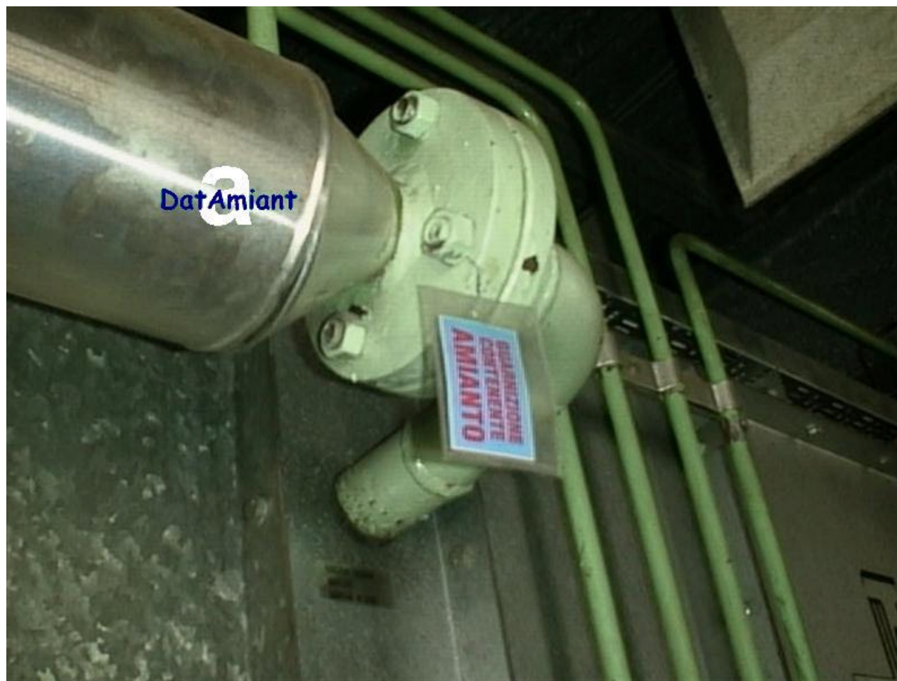
Locali con impianti tecnici di azienda di prodotti per centrali telefoniche Valvola con guarnizione contenente amianto "etichettata"
