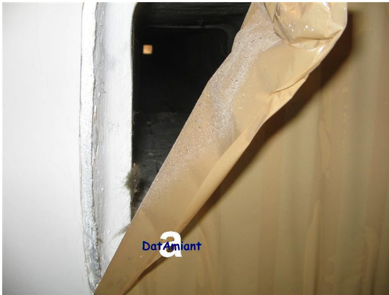
Locale di servizio di ambulatorio sanitario Vista dell'interno di canna fumaria in cemento amianto di inceneritore per rifiuti sanitari dismesso (dettaglio)
