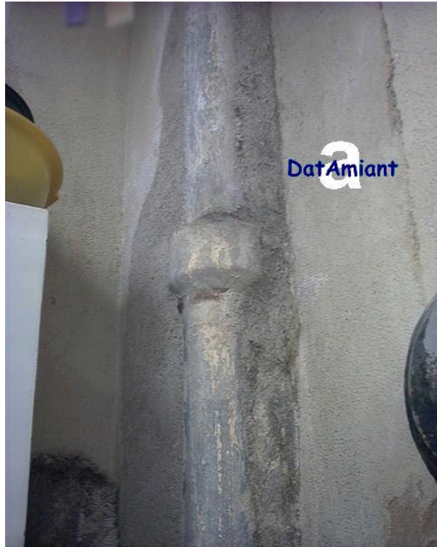
Balcone di un appartamento Pluviale in cemento amianto parzialmente murato
