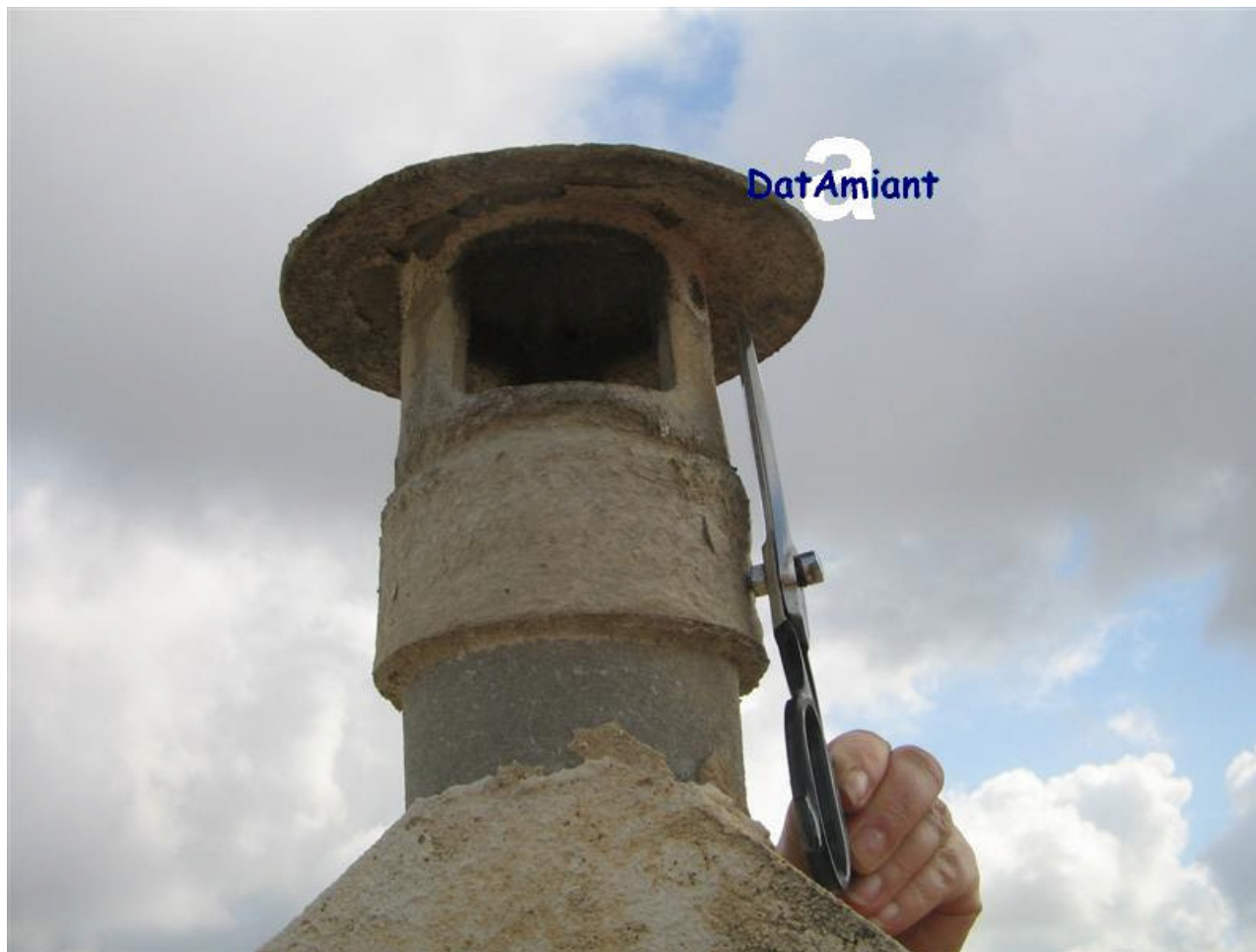
Terrazza di edificio con uffici ed appartamenti Comignolo di canna di sfiato in cemento amianto (dettaglio)
