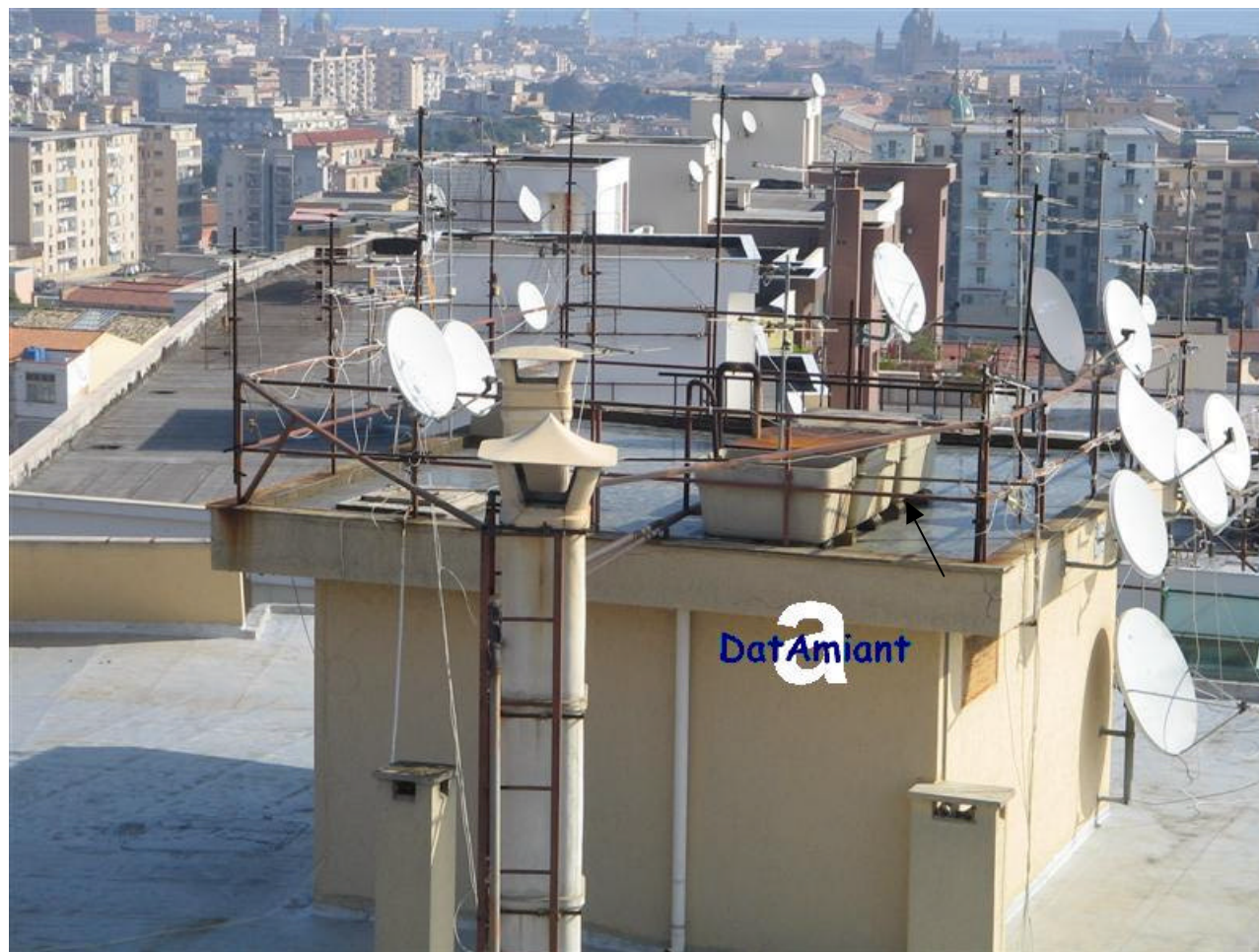
Piano attico di edificio con uffici e appartamenti Vasi espansori di impianto riscaldamento in cemento amianto
