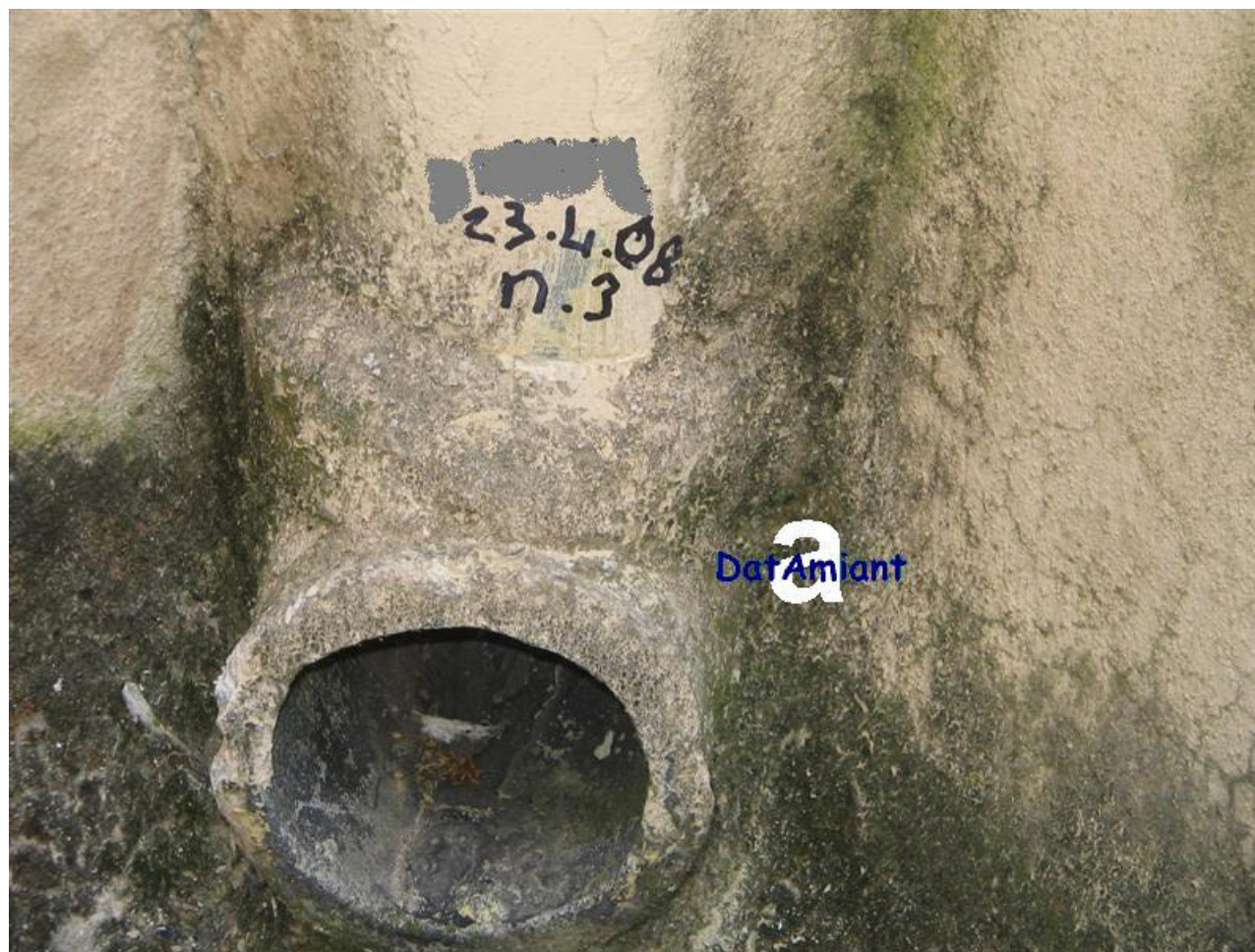
Balcone di edificio con uffici Base di pluviale in cemento amianto (dettaglio)
