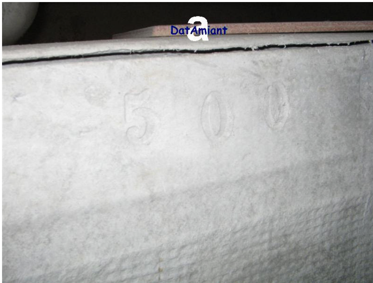
Locale seminterrato di edificio con uffici e appartamenti Superficie di serbatoio idrico da 500 l in cemento amianto (dettaglio)
