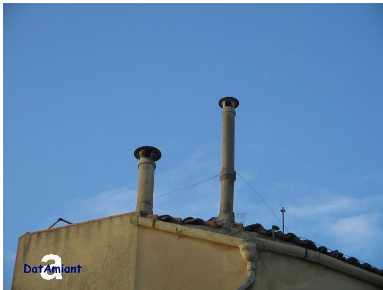
Tetto di abitazione Canne fumarie e comignoli in cemento amianto
