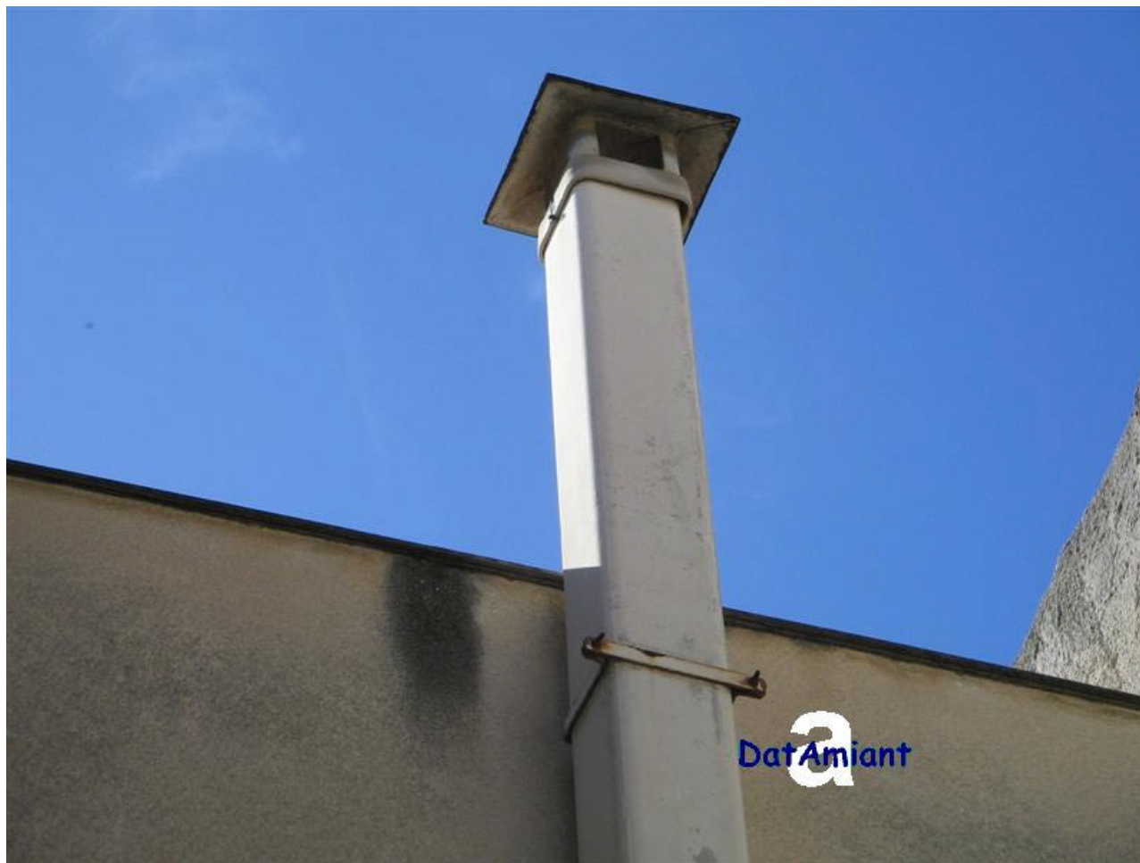
Esterno edificio con ambulatorio sanitario Tratto finale e comignolo di canna fumaria in cemento amianto di inceneritore per rifiuti sanitari dismesso (dettaglio)
