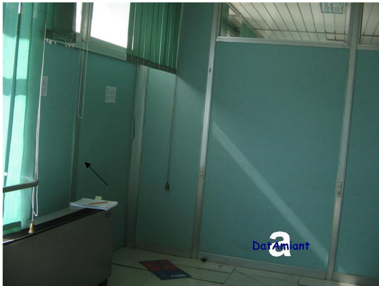
Iterni di edificio di una banca ad uso C.E.D. Pannelli perimetrali contenenti amianto crisotilo (dettaglio)
