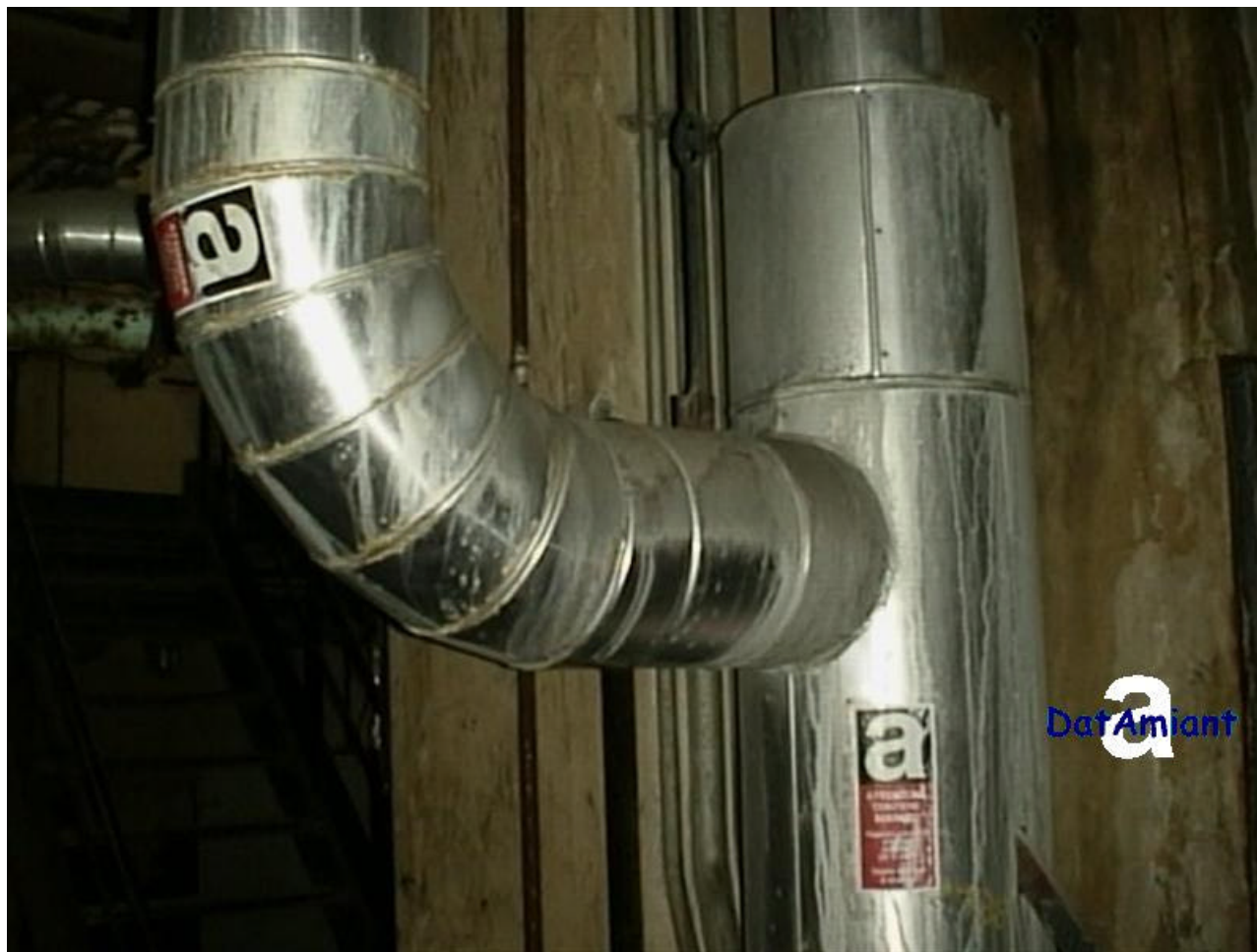
Impianto petrolchimico Condotte di vapore coibentate con materiale contenente amianto friabile
