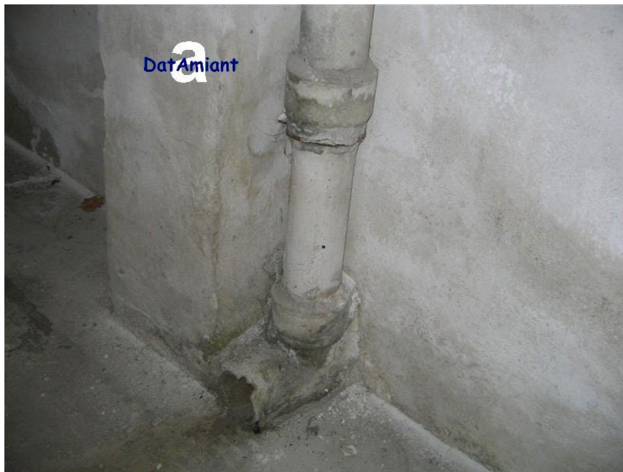
Azienda di tessitura e filatura dismessa Pluviale in cemento amianto danneggiato posizionato all'interno delle aree di lavoro
