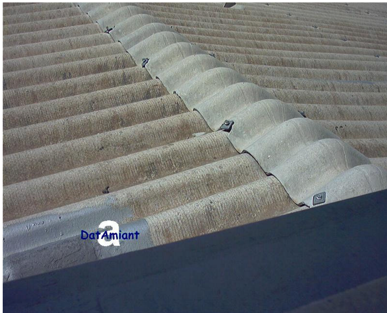
Capannone industriale Tetto con copertura in lastre ondulate in cemento amianto (dettaglio)
