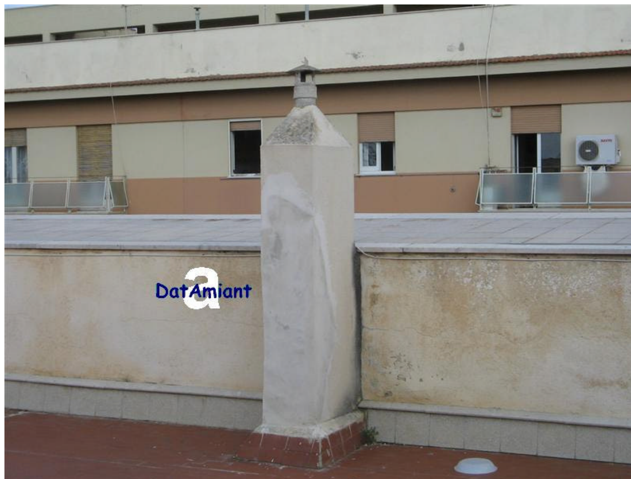
Terrazza di edificio con uffici ed appartamenti Canna di sfiato in cemento amianto confinata dentro muratura
