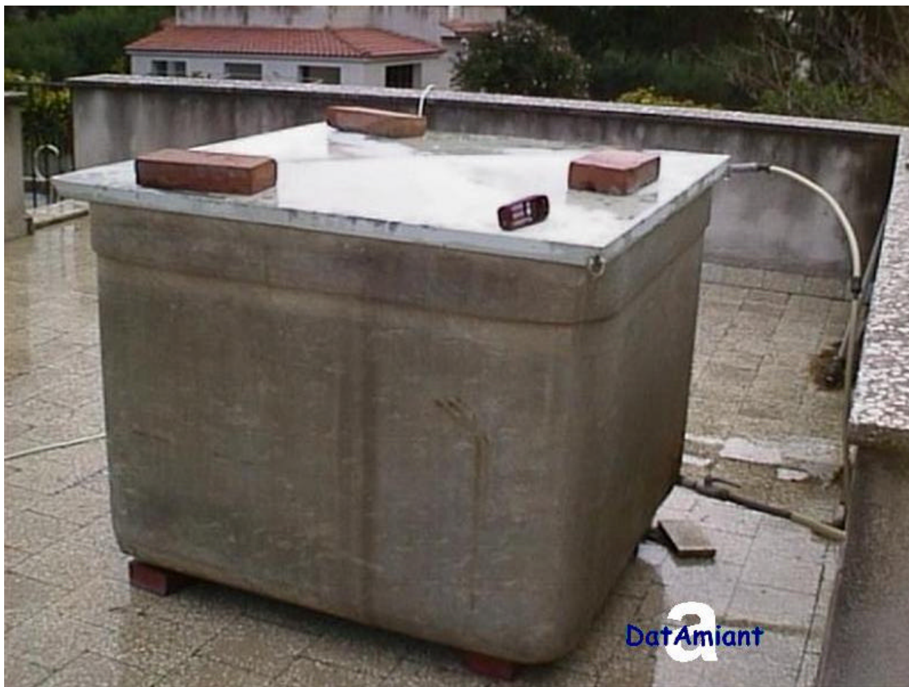
Terrazza di villetta Serbatoio idrico in cemento amianto
