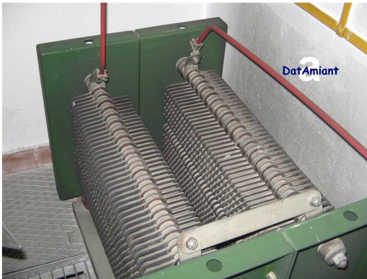
Sotto Stazione Elettrica SSE delle Ferrovie Resistenze prova terra con guarnizioni in amianto
