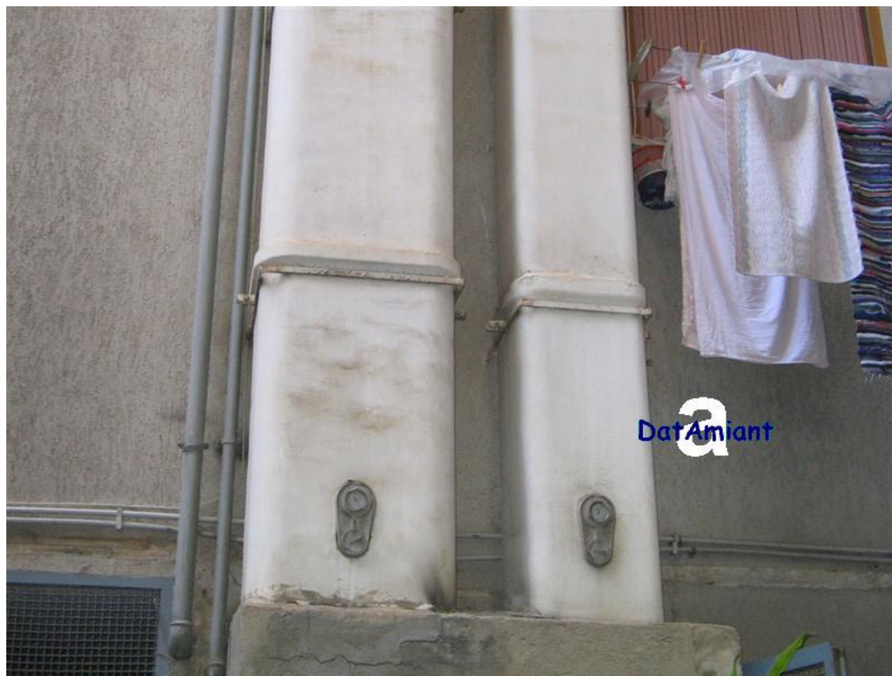
Edificio con uffici e appartamenti Base di canne fumarie di caldaie in cemento amianto (dettaglio)
