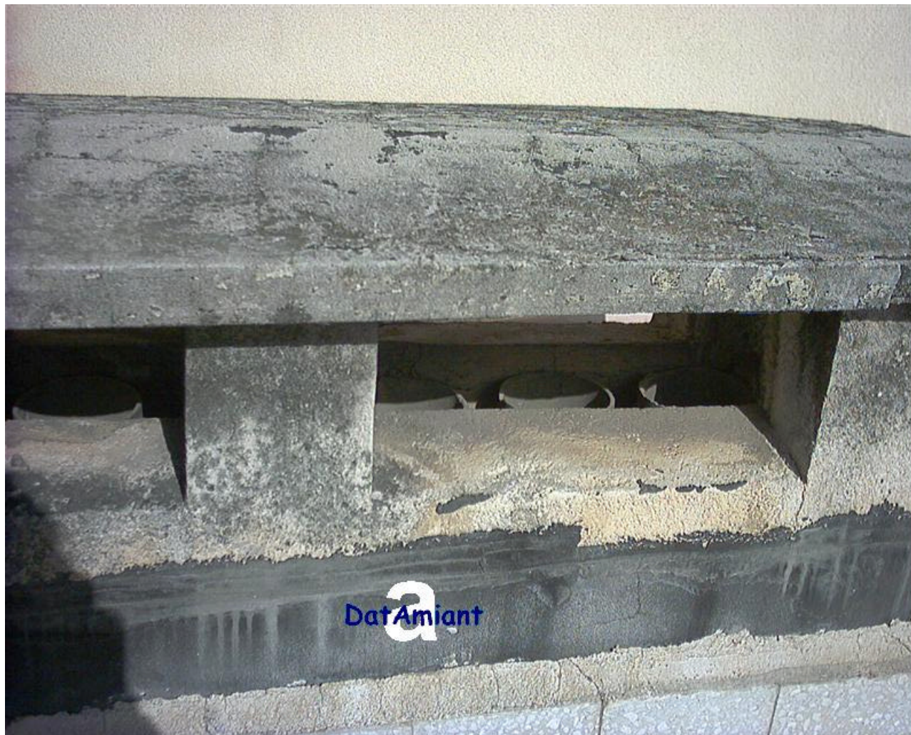
Terrazza di edificio con appartamenti Uscite delle condotte di ventilazione degli impianti igienico-sanitari in cemento amianto (dettaglio)
