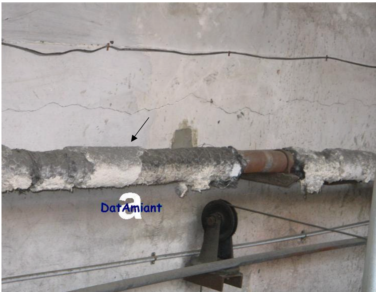
Locale caldaie di azienda di tessitura e filatura dismessa Tubazione coibentata con rivestimento esterno contenente amosite
