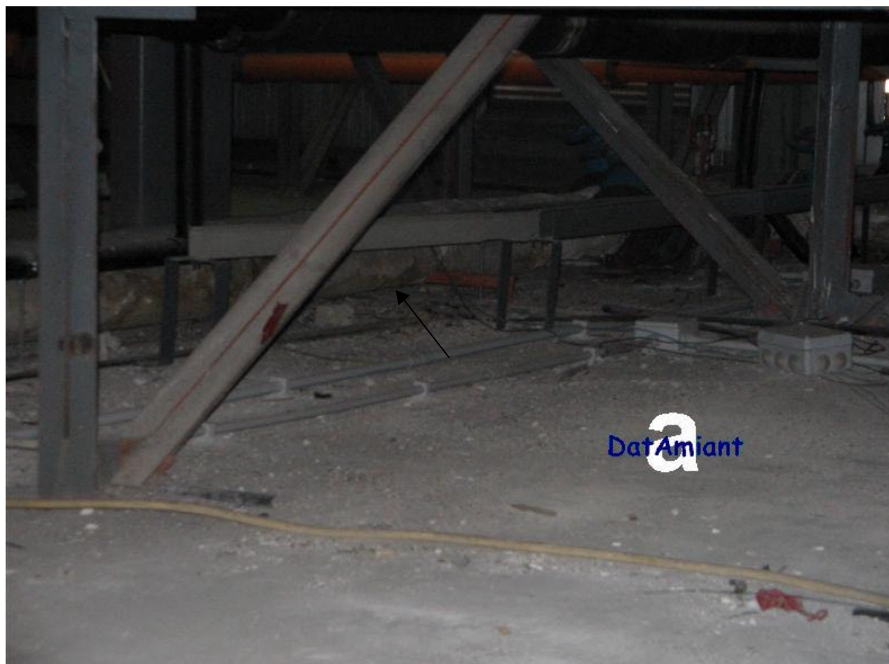
Interpiano tecnico di edificio di banca Tubazione calda coibentata con rivestimento esterno di impasto di cemento e crisotilo deteriorato
