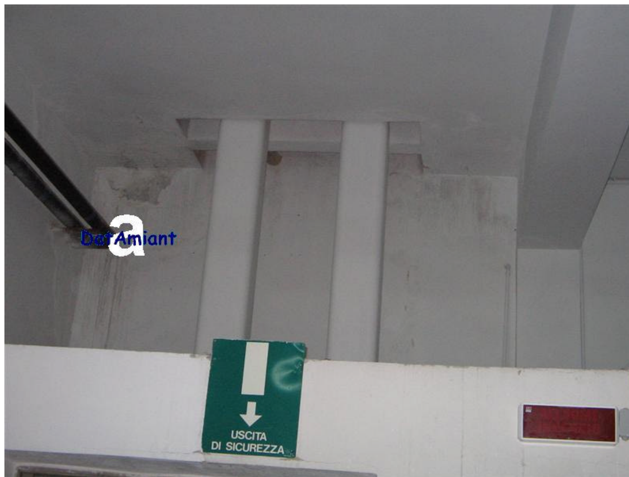
Garage di edificio con uffici Canne di aspirazione fumi in cemento amianto sopra vano tagliafuoco (dettaglio)
