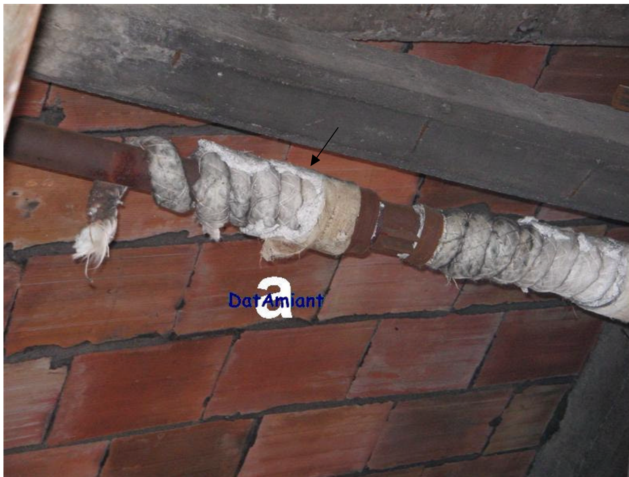
Locale caldaie di azienda di tessitura e filatura dismessa Tubazione coibentata con rivestimento esterno contenente amosite
