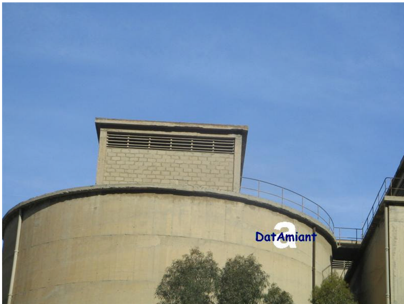
Cementeria Finestrature con grigliati in cemento amianto
