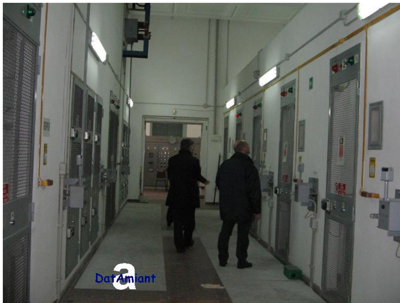
Sotto Stazione Elettrica SSE delle Ferrovie Celle interruttori extra rapido con parti d'impianto contenenti amianto
