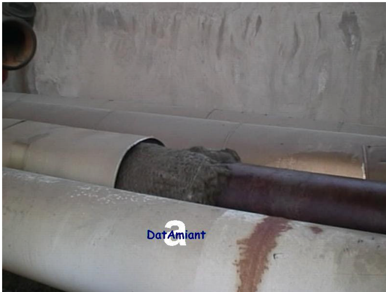
Impianto petrolchimico Condotto di vapore coibentato con materiale friabile a vista
