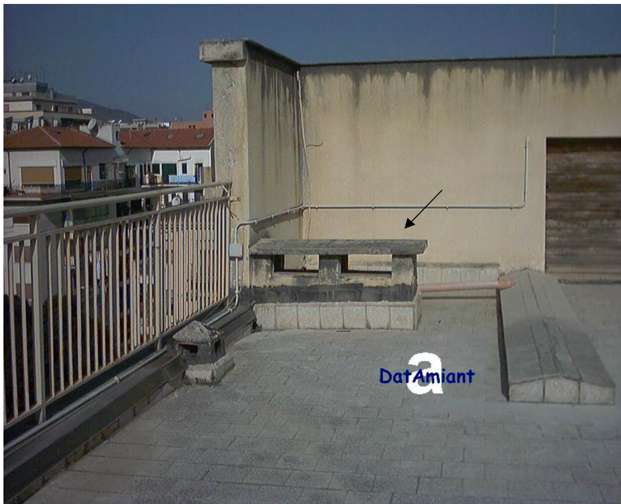
Terrazza di edificio con appartamenti Sede delle condotte di ventilazione degli impianti igienico-sanitari in cemento amianto
