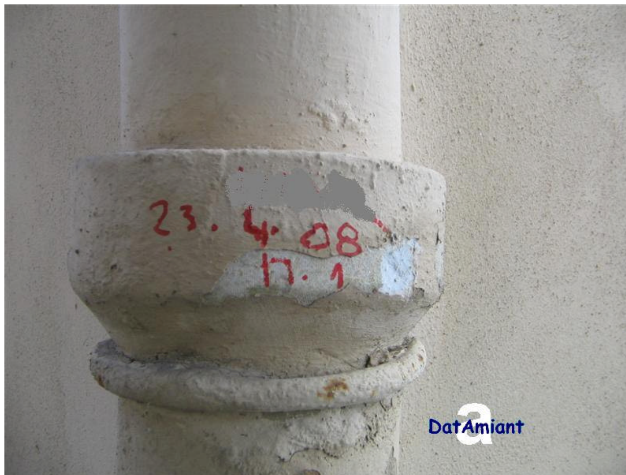
Terrazza di edificio con uffici Giunto di pluviale in cemento amianto
