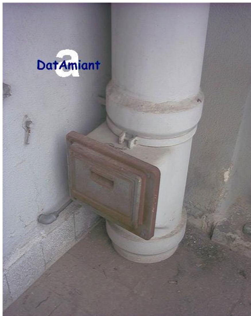
Balcone di un appartamento Tubo per rifiuti domestici in cemento amianto integro (dettaglio)
