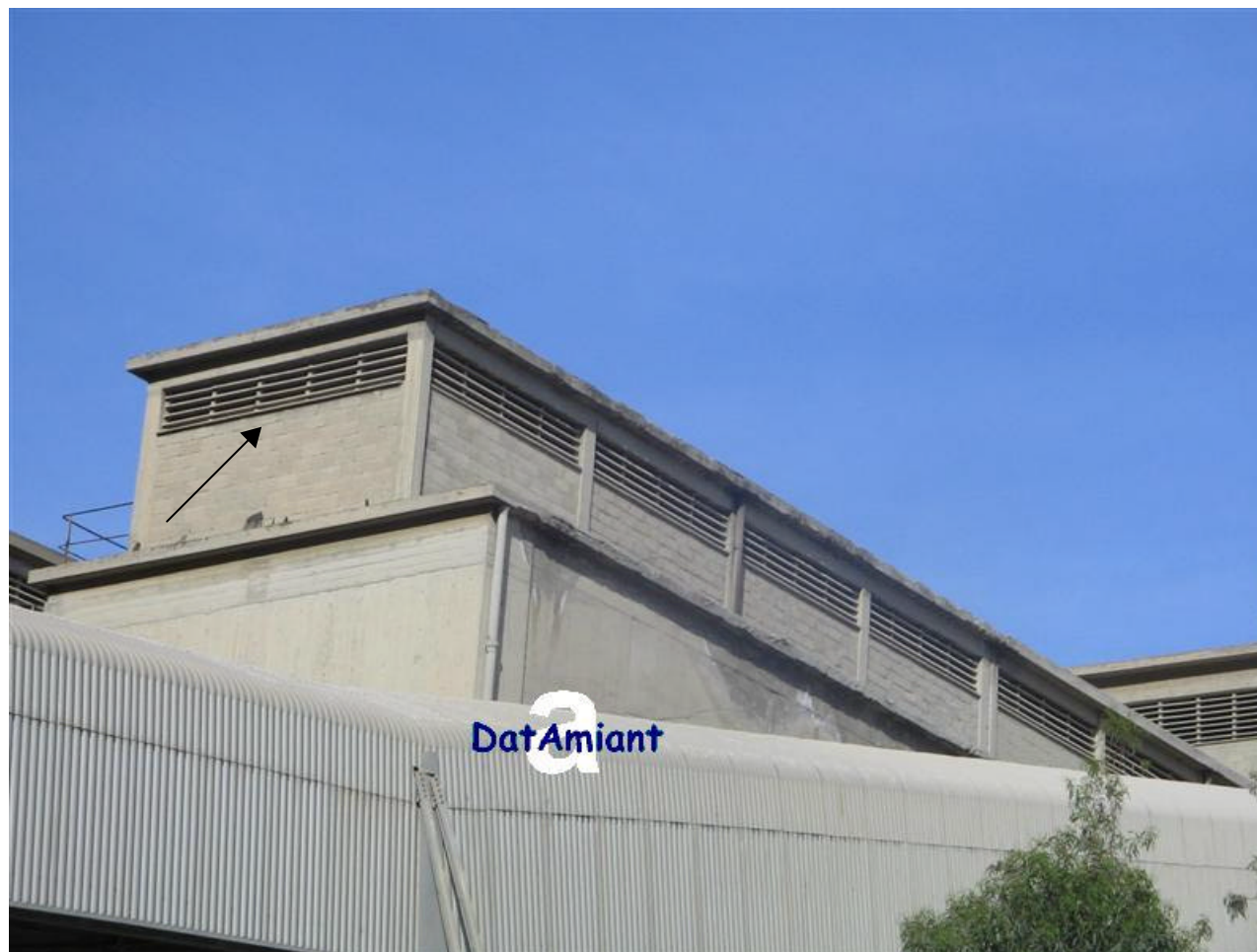
Cementeria Finestrature con grigliati in cemento amianto
