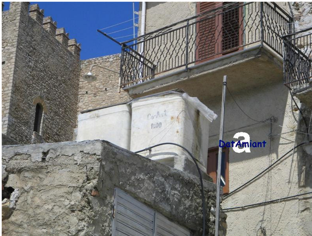
Tetto di garage Serbatoi idrici da 1000 l in cemento amianto
