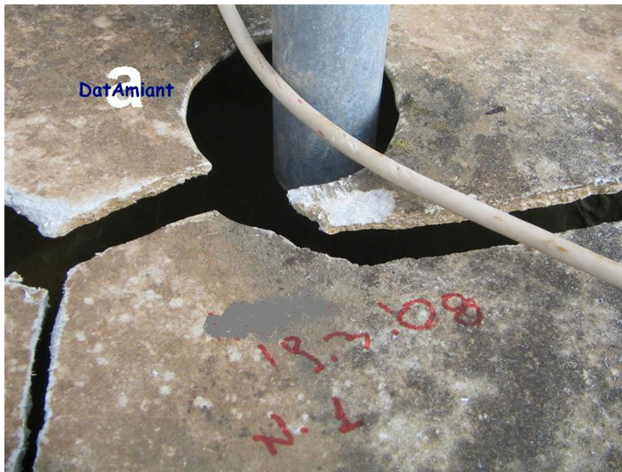
Terrazza di edificio con uffici e appartamenti Coperchio danneggiato di vaso espansore di impianto riscaldamento in cemento amianto (dettaglio)
