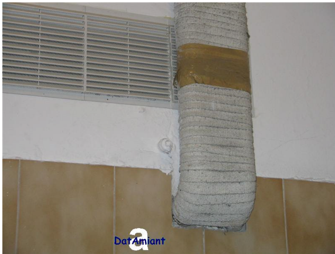
Toilette di ristorante Base del condotto di ventilazione fasciato con tessuto di crisotilo
