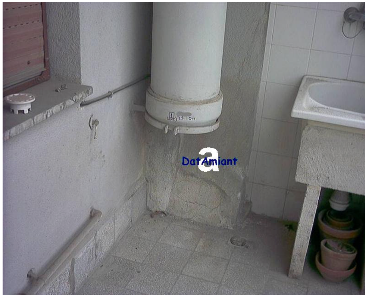
Balcone di un appartamento Tubo per rifiuti domestici in cemento amianto privo di base con sportello
