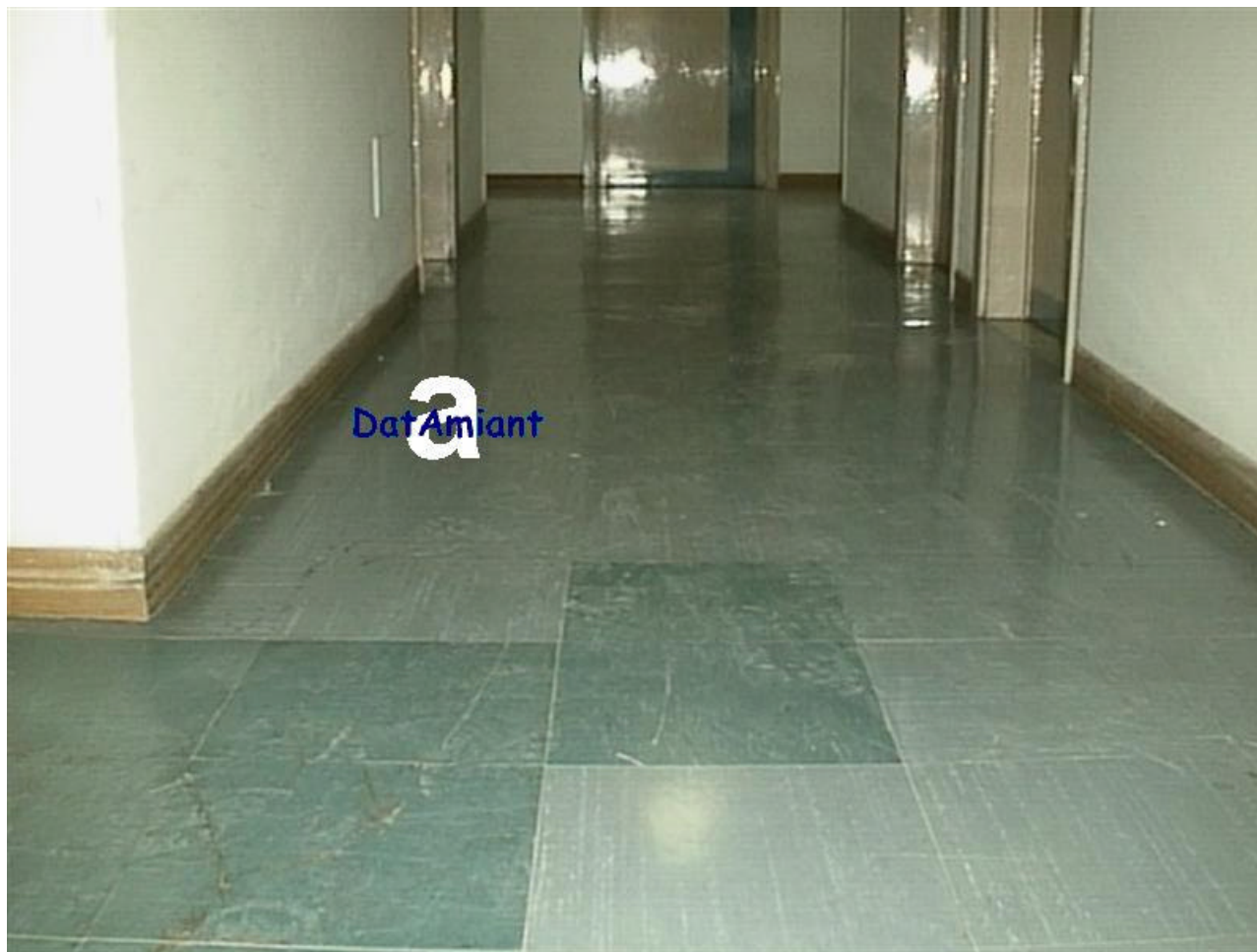
Corridoio di uffici Pavimentazione in mattonelle in vinil amianto parzialmente sostituite
