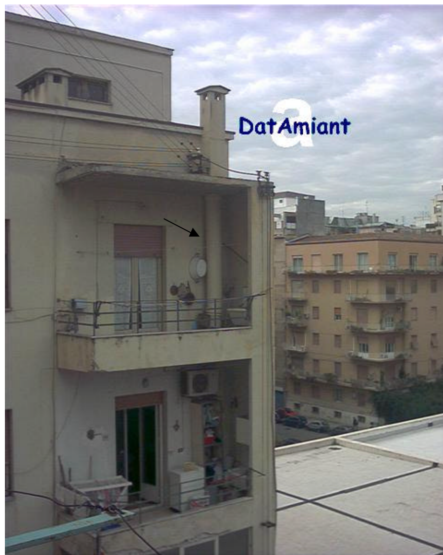
Edificio con appartamenti Tubo per rifiuti domestici in cemento amianto
