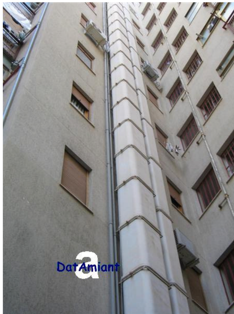
Edificio con uffici e appartamenti Canne fumarie di caldaie per riscaldamento locali in cemento amianto
