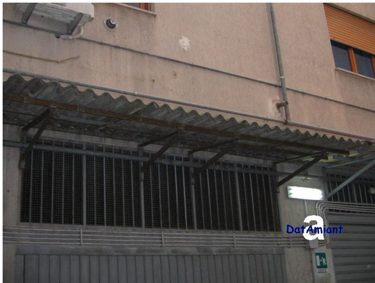
Esterno garage Tettoia con lastre ondulate in cemento amianto
