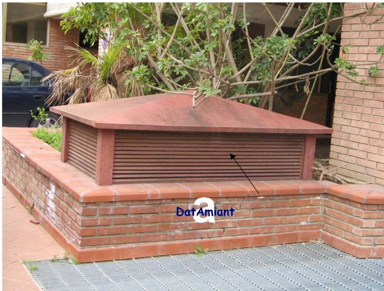
Esterno di edificio con uffici Sede delle uscite delle canne di aspirazione fumi in cemento amianto al di sopra del vano tagliafuoco in garage (dettaglio)
