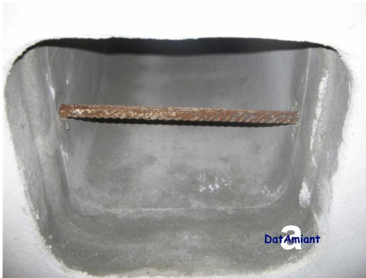
Soffitto di vano tagliafuoco in garage di edificio con uffici l mbocco di una canna di aspirazione fumi in cemento amianto
