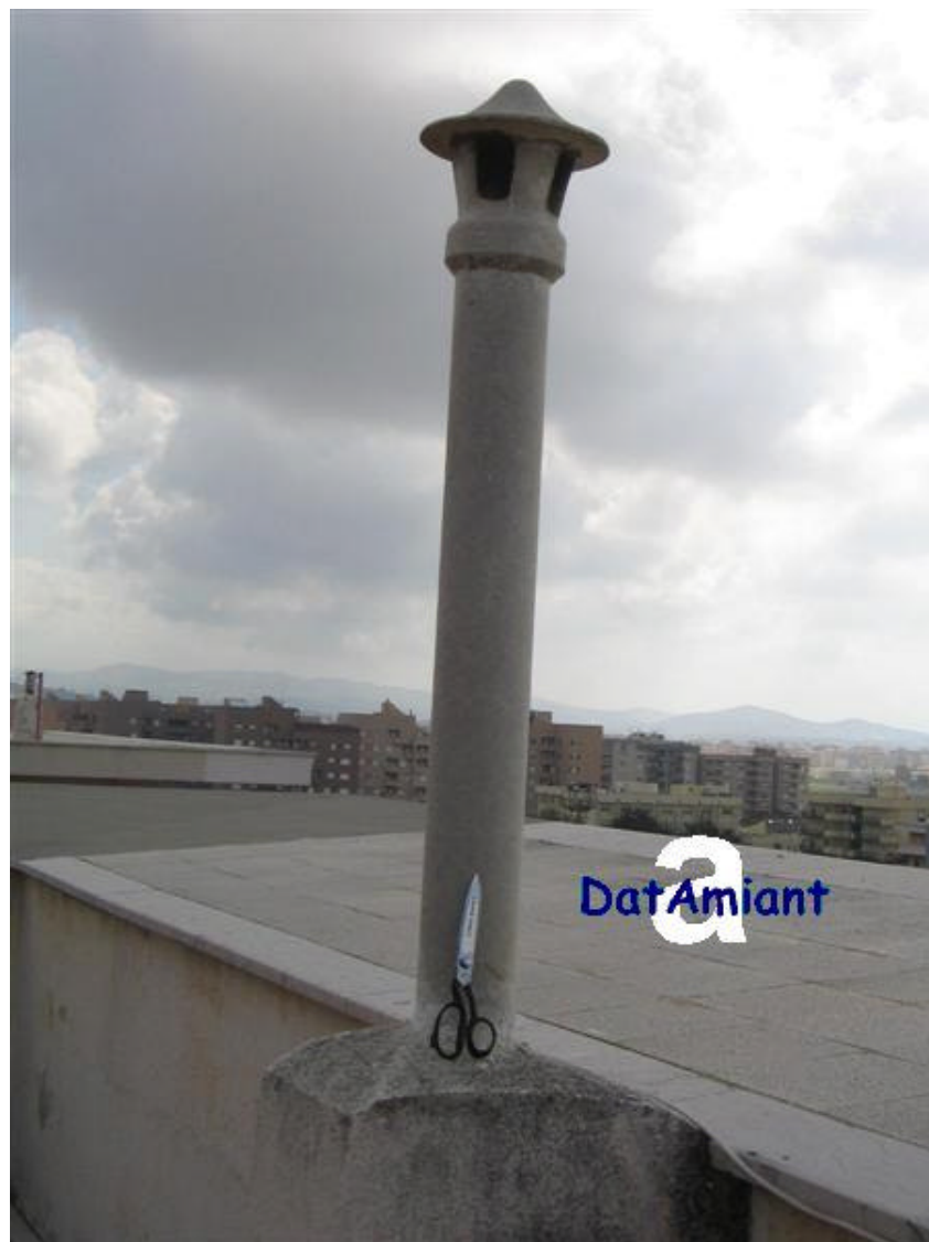
Terrazza di edificio con uffici ed appartamenti Canna di sfiato in cemento amianto
