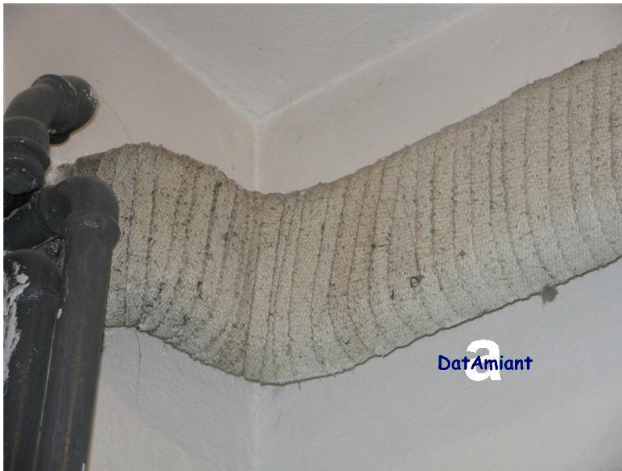
Toilette di ristorante Parte alta del condotto di ventilazione fasciato con tessuto di crisotilo
