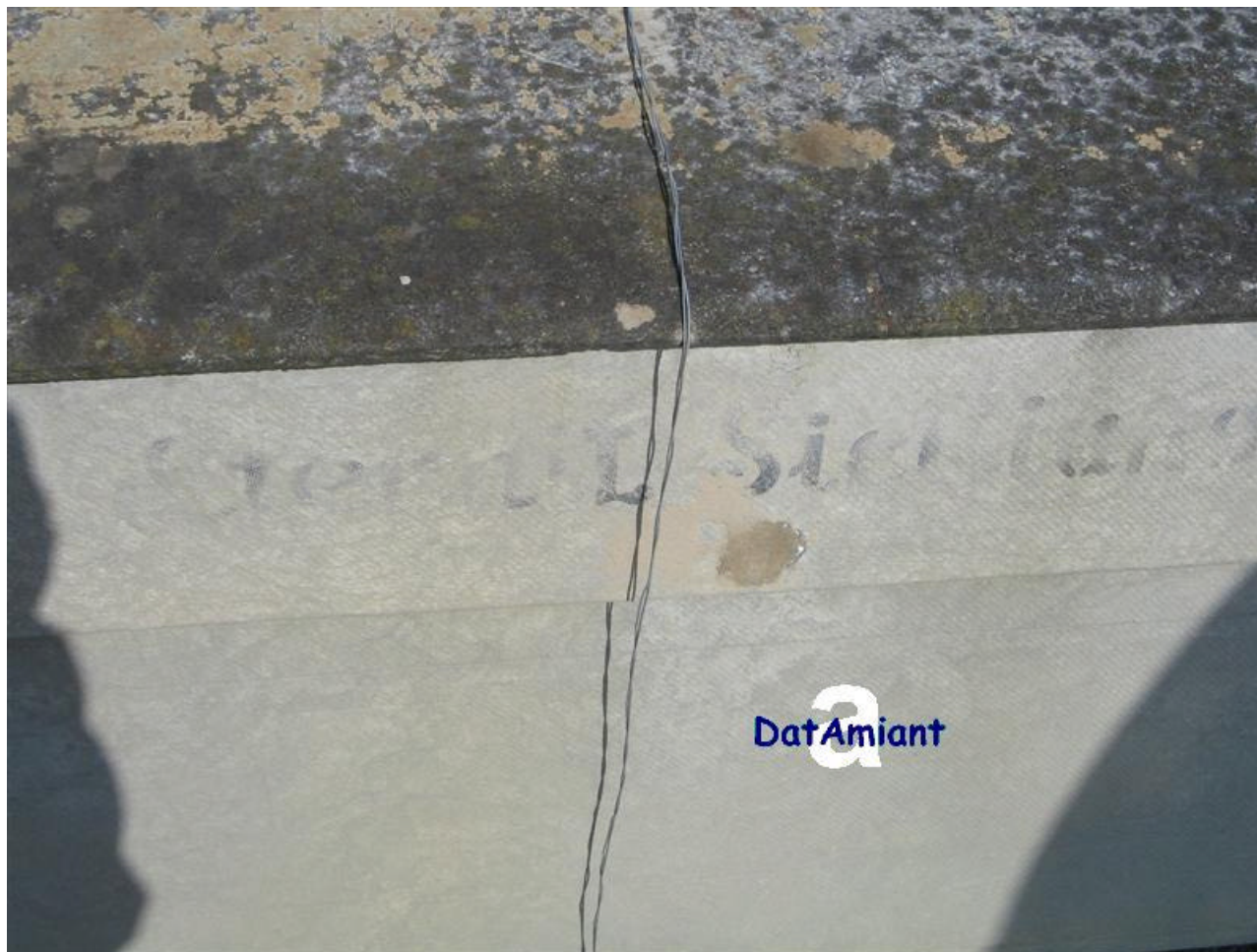
Piano attico di edificio con uffici e appartamenti Superficie di un vaso espansore di impianto riscaldamento in cemento amianto (dettaglio)
