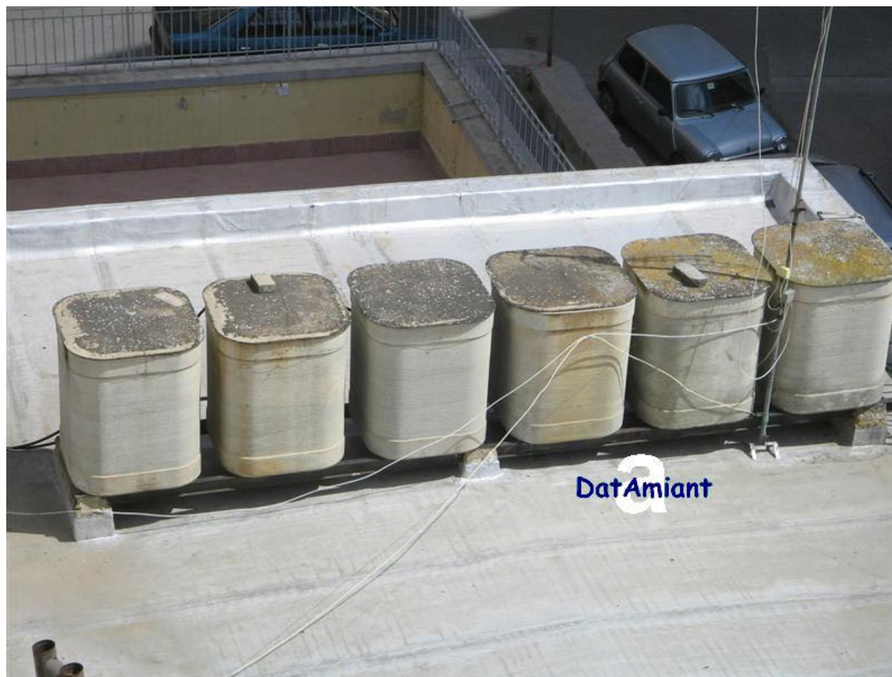
Tetto di edificio con uffici Gruppo di serbatoi idrici in cemento amianto
