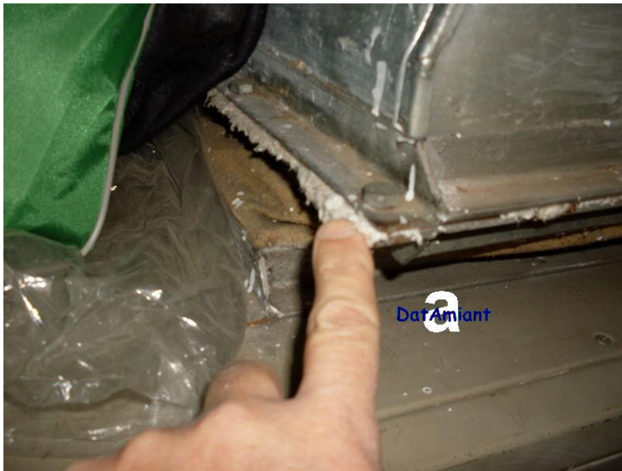
Abitazione privata Guarnizione in cordino di crisotilo di un giunto del condotto di ventilazione (dettaglio)
