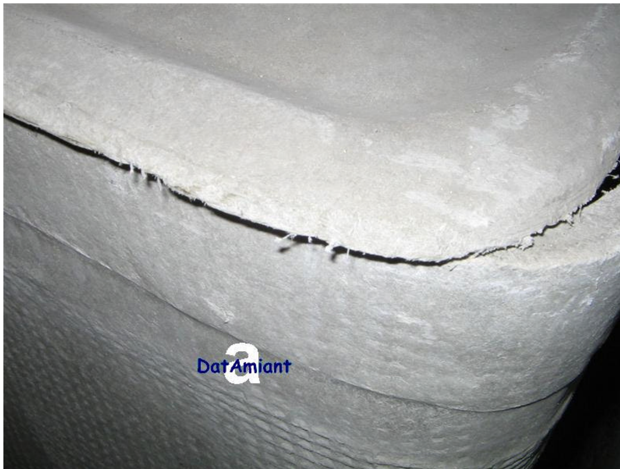
Locale seminterrato di edificio con uffici e appartamenti Serbatoio idrico in cemento amianto con ciuffi di fibre emergenti dal coperchio (dettaglio)
