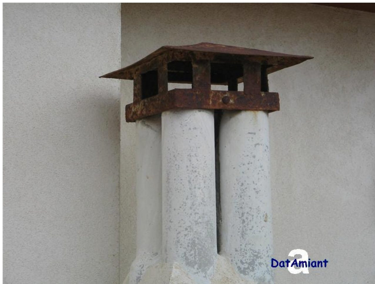
Terrazza di edificio con uffici ed appartamenti Gruppo di canne di sfiato in cemento amianto
