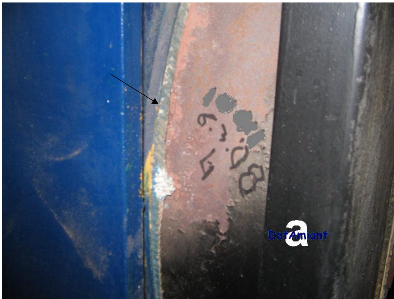
Locale caldaie di edificio con uffici e appartamenti Guarnizione di caldaia a treccia contenente fibre di crisotilo e fibre di natura organica (dettaglio)
